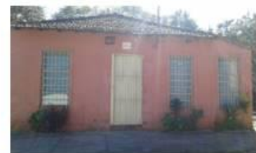
Parte exterior Foto: Cândida Benitez
