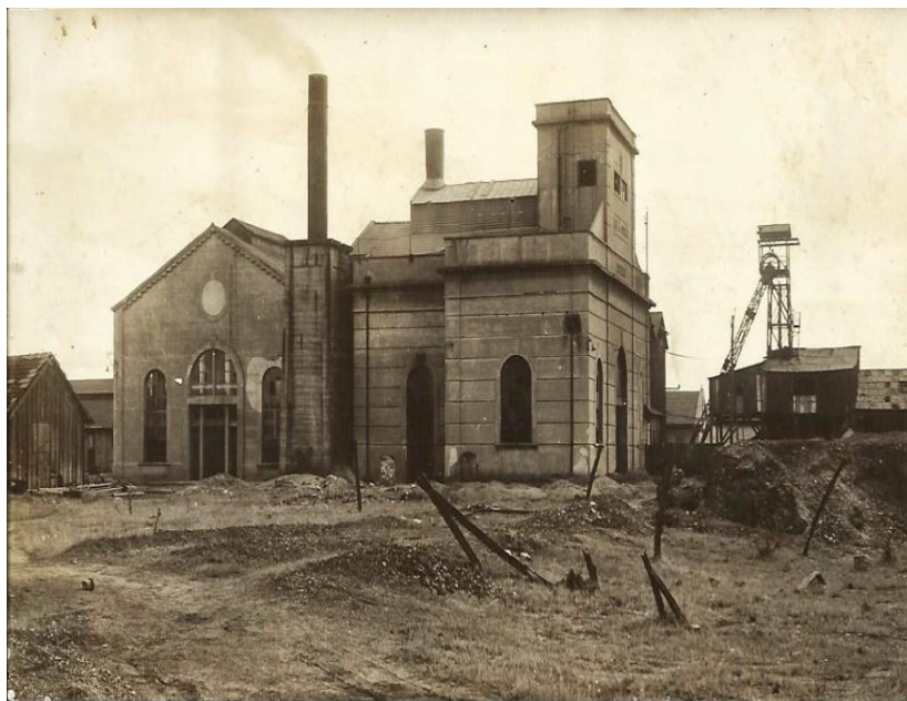
Figura 5 – Complexo industrial carbonífero do Poço 1 (à direita) e Usina Termoelétrica (à esquerda) em 1935.
