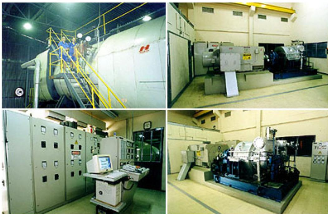
Figura 1: Fotos da caldeira fumotubular, da turbina e da sala de controle
