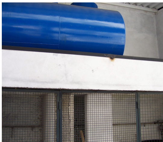
Figura 8: Tanque de óleo diesel.
