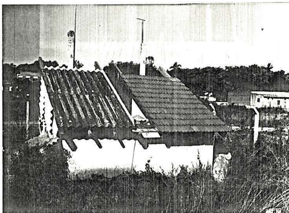
FIGURA VI.2 - Bancada de testes com cobertura modelo em cimento-amianto envelhecido.
