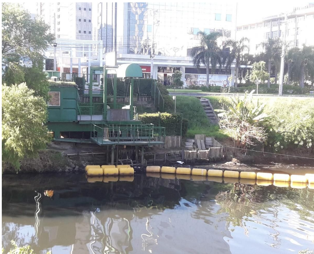
Figura 46: Eco- barreira instalada no leito do arroio Dilúvio
