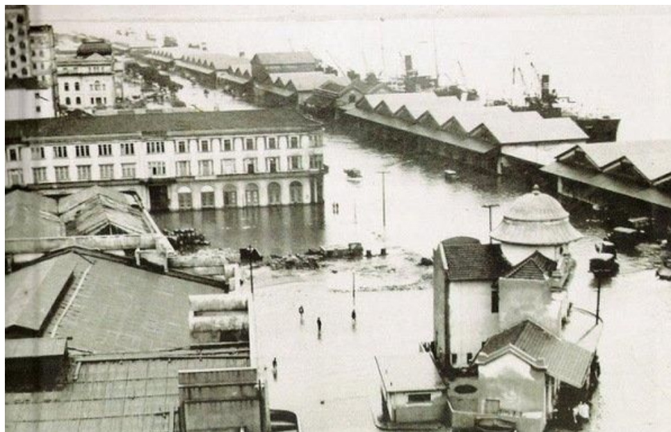
Figura 31: Enchente de 1941 vista do Centro de Porto Alegre.
