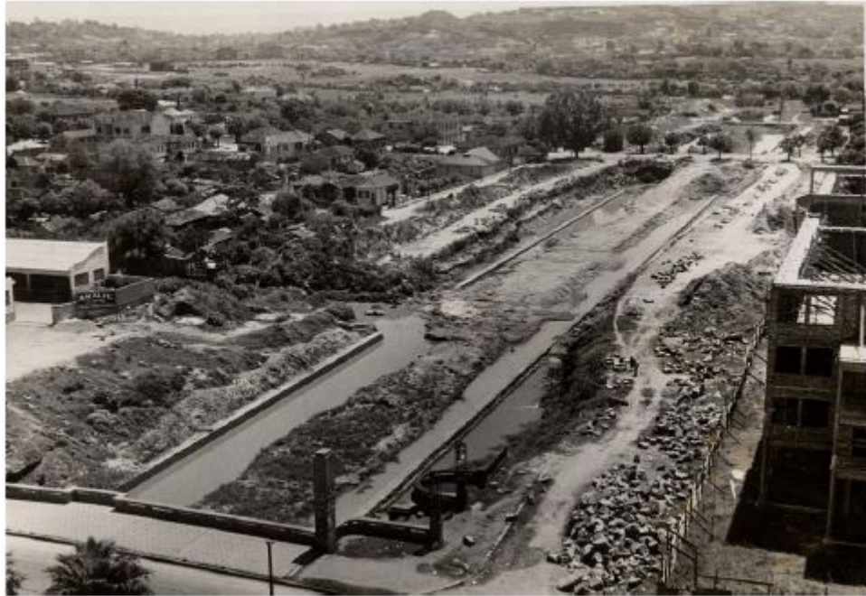
Figura 30: Obra de canalização do Arroio Dilúvio na cidade de Porto Alegre.
