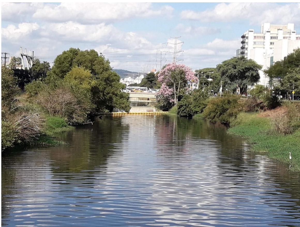
Figura 10 — Parte de trecho canalizado do Arroio Dilúvio - Porto Alegre
