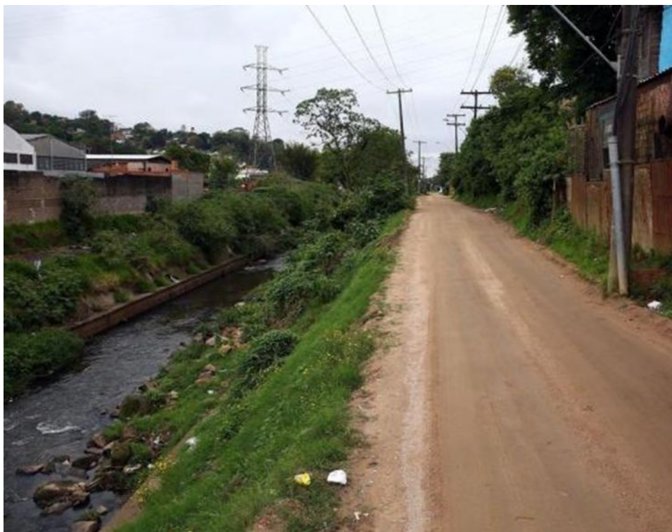
Figura 45 — Parte de trecho canalizado do Arroio Dilúvio - Porto Alegre
