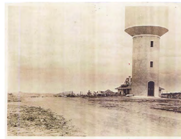
Fig. 187. Caixa da água. Bairro Petrópolis. s/f Fonte: Movimento Petrópolis Vive
