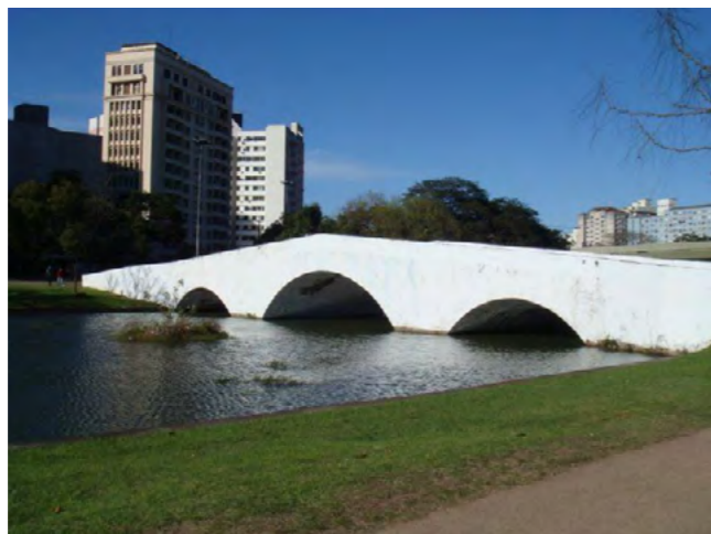
Fig. 166. Ponte de Pedra. Porto Alegre Fonte: Arquivo Pessoal
