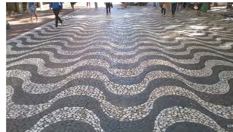
Fig. 125. Calçada em Rua da Praia, Porto Alegre. RS, Brasil Fonte: https://www.tripadvisor.com.br/LocationPhotoDirectLink-g303546-d555087-i246288017-Da_Praia_Street-Porto_Alegre_State_of_Rio_Grande_do_Sul.html
