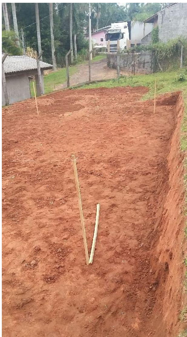
Figura 19 - Terreno com as marcações para construção da estufa.
