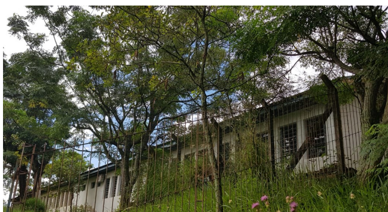
Figura 3 - Prédio principal da escola.
