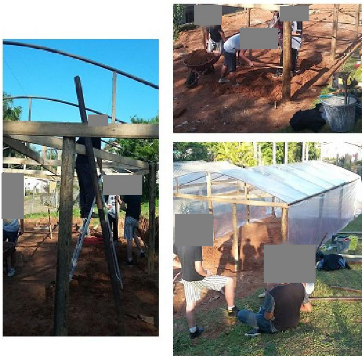
Figura 27 - Construção da estufa.
