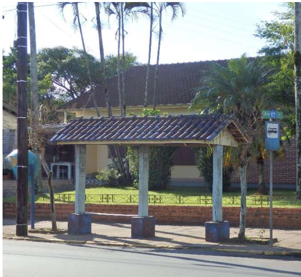
Figura 5 – Abrigo de ônibus/edificação
