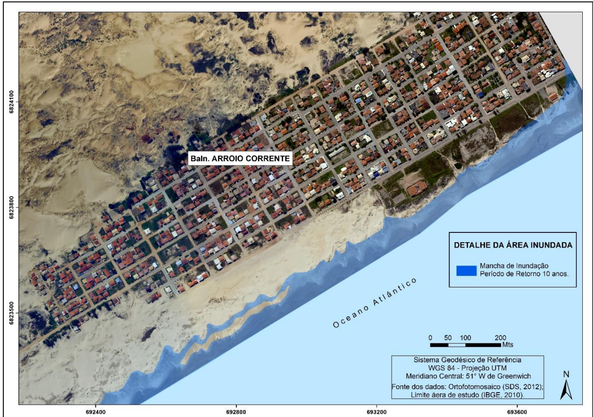
Figura 38: Detalhe do Balneário Arroio Corrente.
