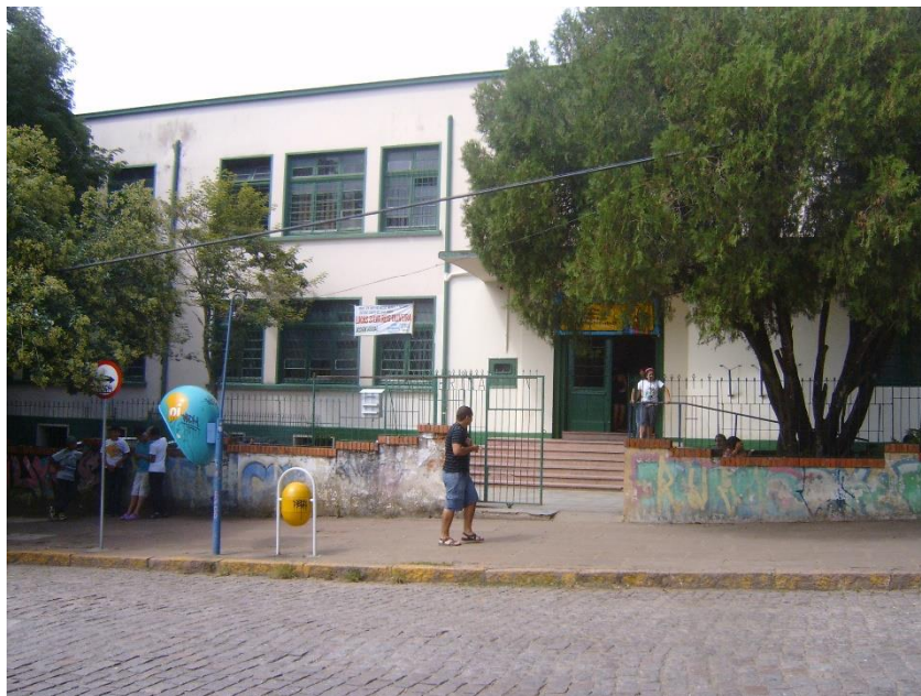
Figura 3: Fachada da Escola Anita Garibaldi
