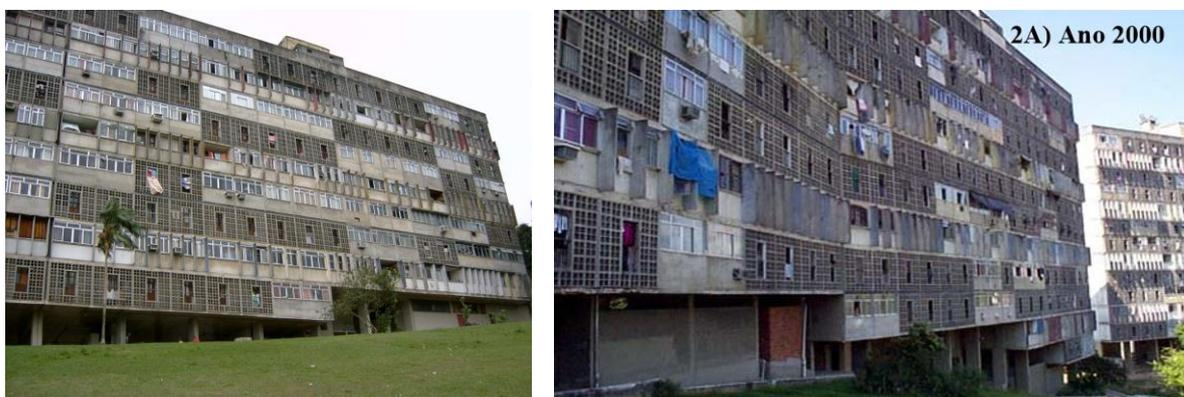
**Figura 97 e Figura 98:** Alterações de fachada.
