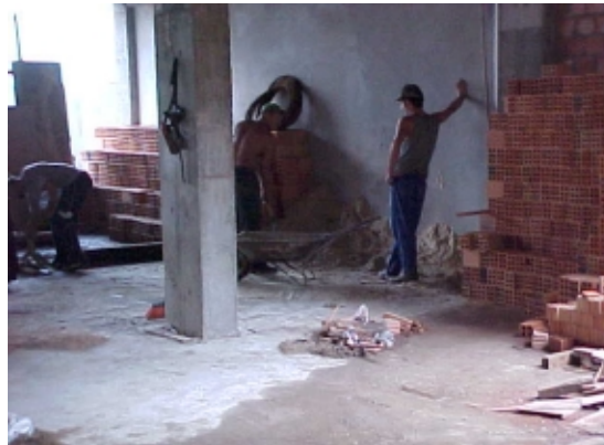
Figura 4.8 - Retirada da areia para a preparação do local de estoque do elevador
