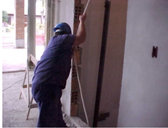
Figura 4.7 - Transporte manual das guias (uma a uma) para dentro da caixa
