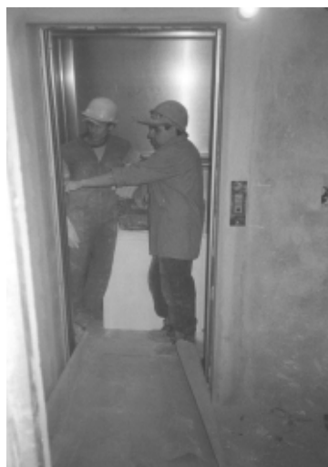
Figura 4.18 - Transporte de sacos de cimento e placas de gesso pelo elevador
