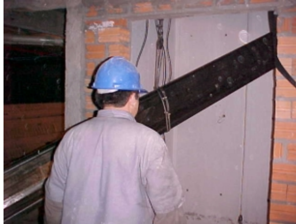
Figura 4.5 - Transporte mecânico do conjunto de guias para dentro da caixa de corrida
