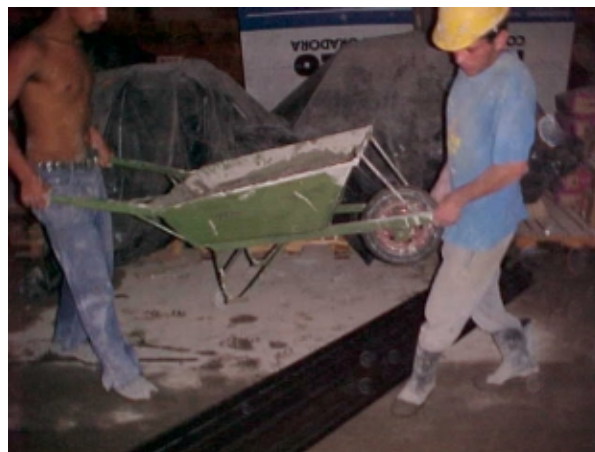
Figura 4.12 - Estoque de guias interrompendo o fluxo de trabalho da obra
