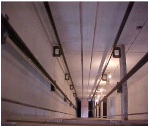
Figura 4.2 - Vista superior da estrutura executada e detalhe da fixação na viga da caixa
