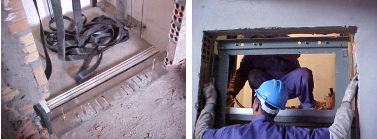
Figura 4.14 - Chapa de piso ou Pré-marco para a colocação das portas
