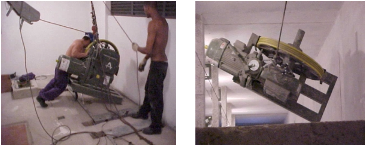
Figura 4.17 - Içamento manual da máquina de tração
