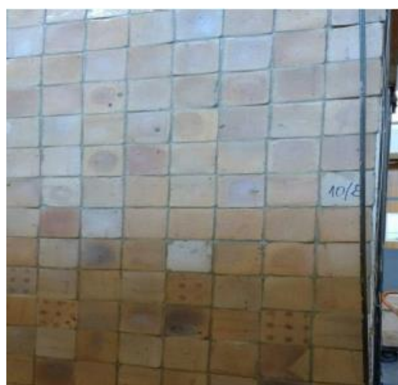
Figura 1 – SVVE revestido com as placas cerâmicas com adição de resíduos
