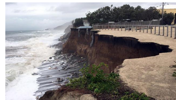
Figura 1 - Erosão irregular da costa ocasionada por sistema de ondas com diferentes direções e frequências de propagação. Foto de Michelle Roberts
