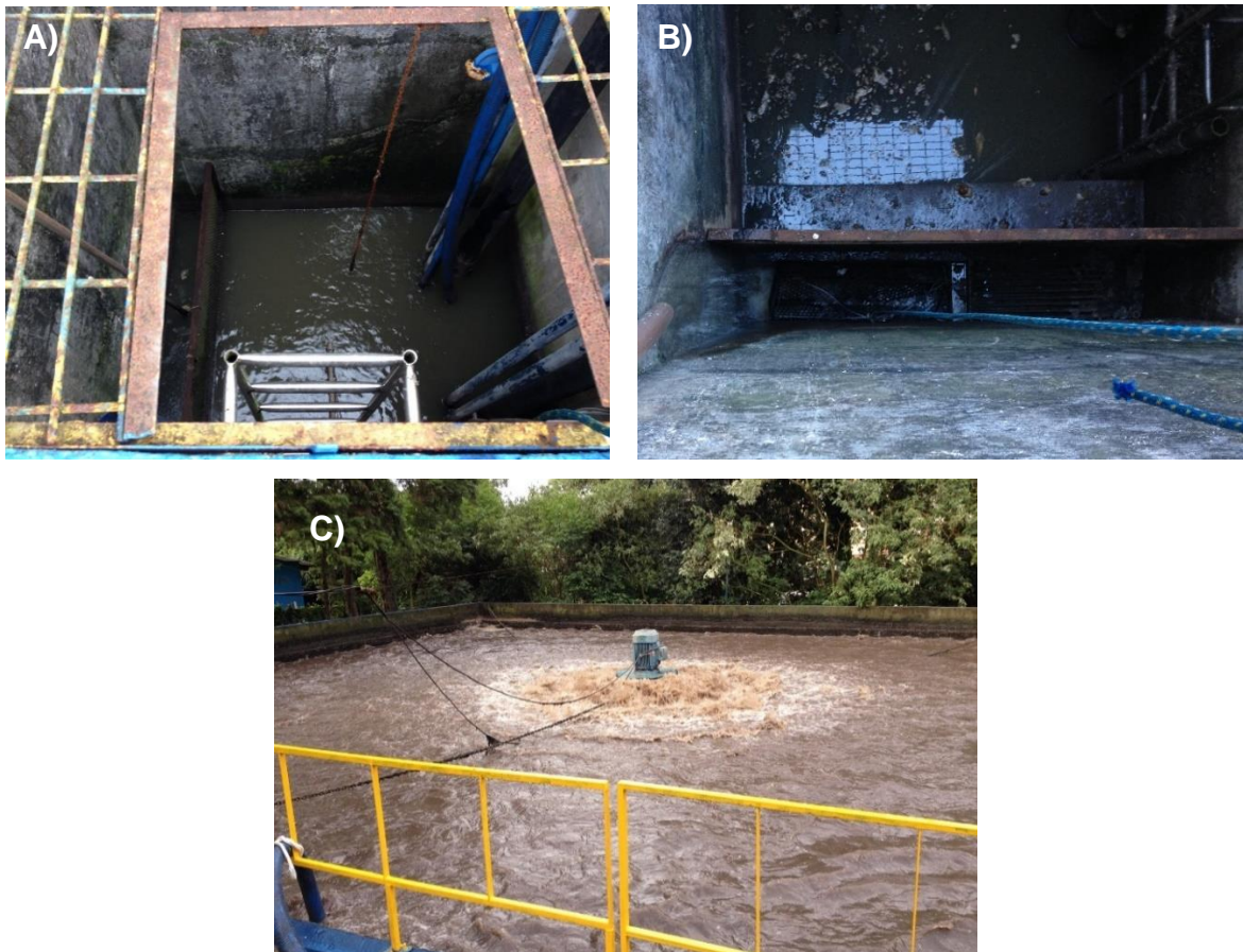
Figura 9 – ETE onde foi coletado o EFD, sendo A) e B) gradeamentos e C) tanque de lodos ativados. (Fotos: Fernando Hamerski)
