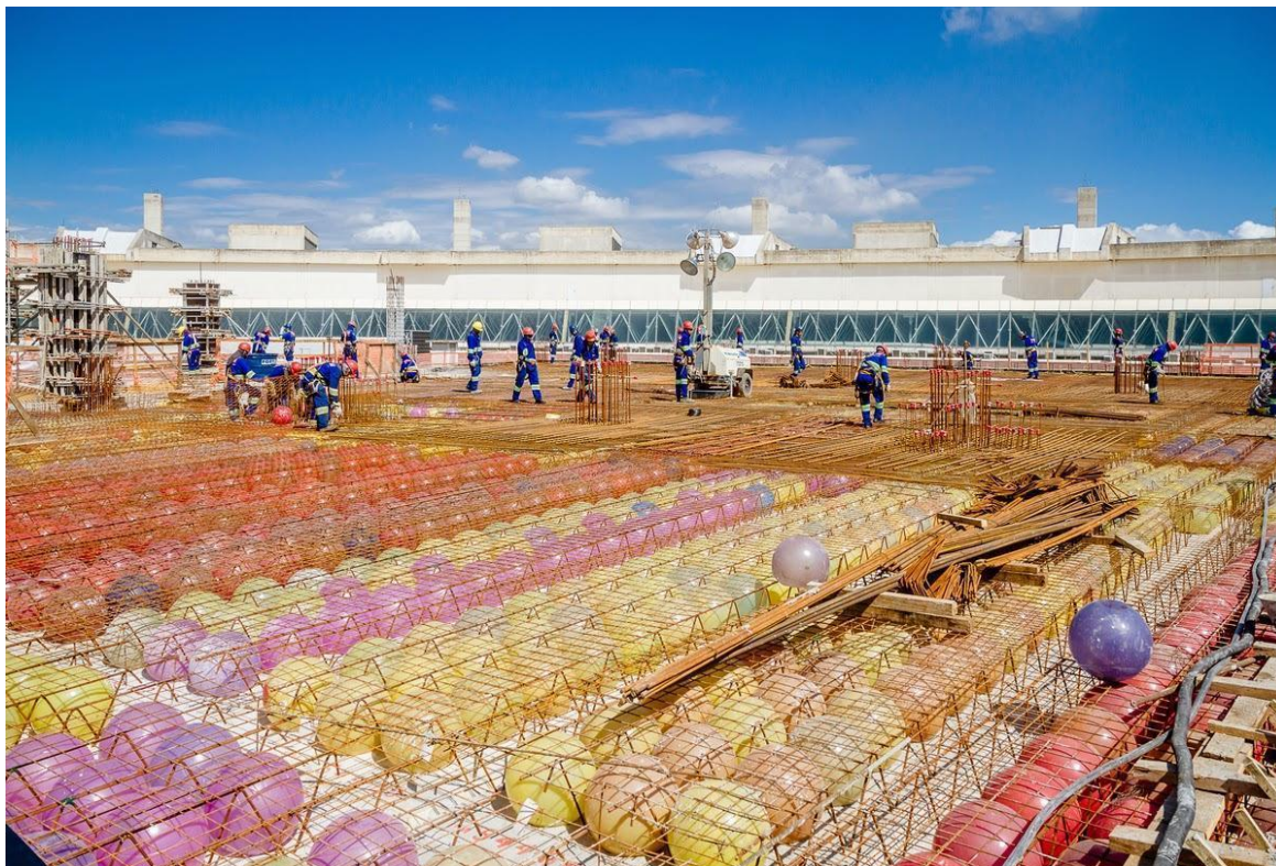
Figura 2 – Tecnologia “Bubble Deck” utilizada na construção do estacionamento do Aeroporto Internacional Tom Jobim, no estado do Rio de Janeiro (12).
