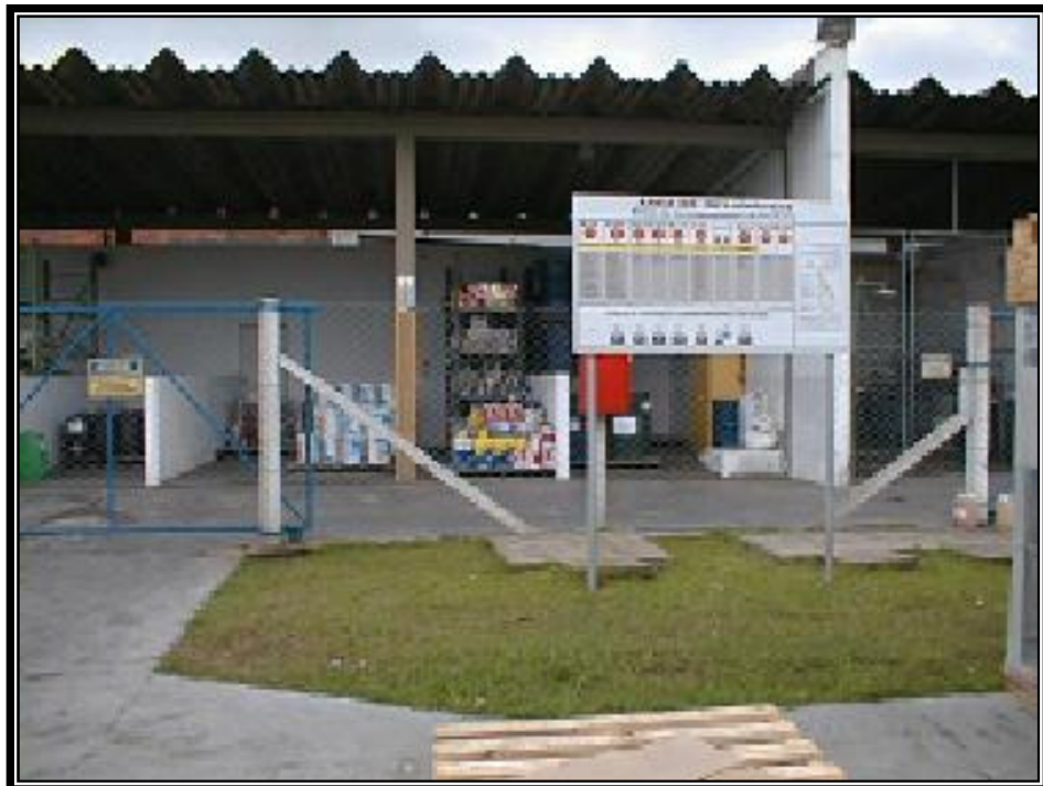
Área de inflamáveis e estocagem temporária de resíduos classe I
