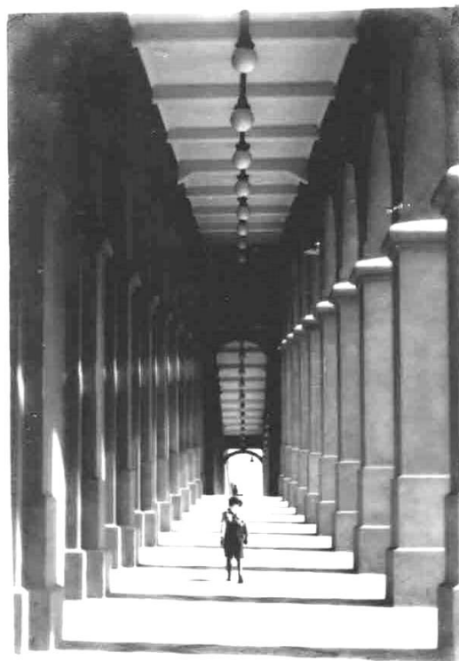
Figura 57 Viaduto Otávio Rocha, Porto Alegre
