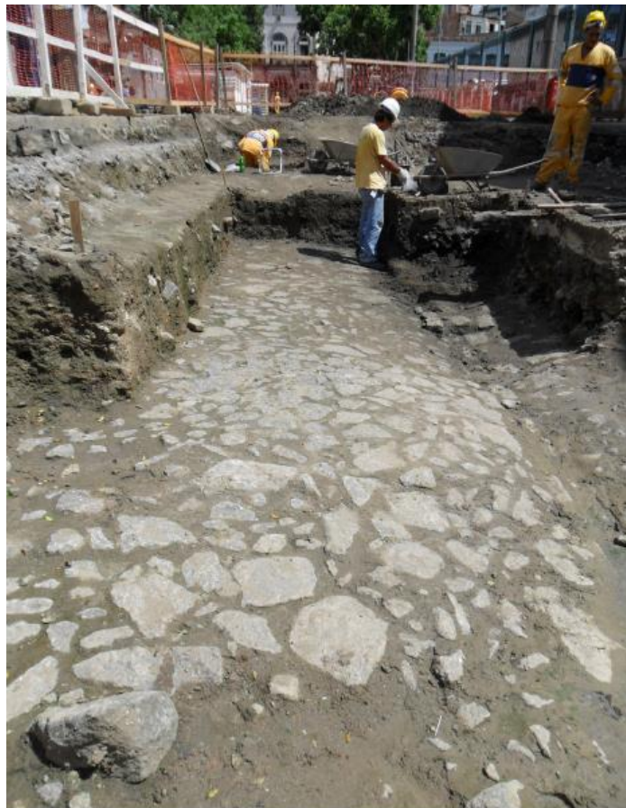
Imagem 6 - Escavação em área ampla, expondo a inclinação do calçamento em direção à canaleta de escoamento de águas pluviais e em direção ao mar
