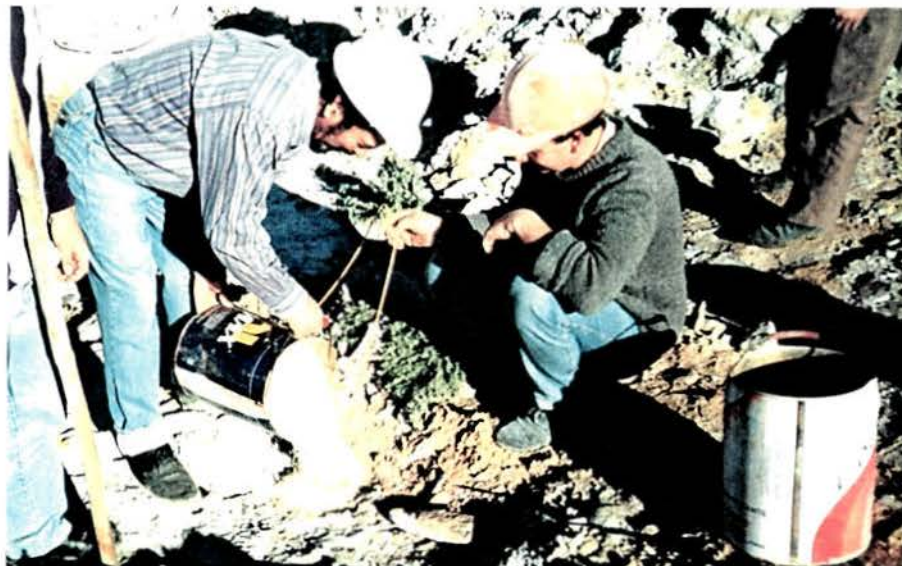
Figura 54. Carregamento dos furos com ANFO.
