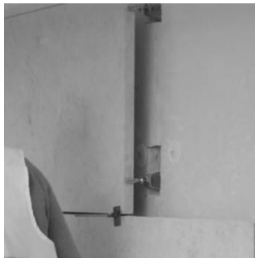
Figura 18 (b) – Revestimento não aderido pétreo mais comumente utilizado em fachadas
