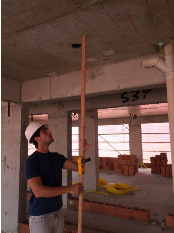
Figura 37 (a)– Uso do nível a laser para mapeamento
