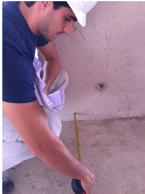
Figura 35 (b) – Medição da distância das linhas de eixo com a face do pilar
