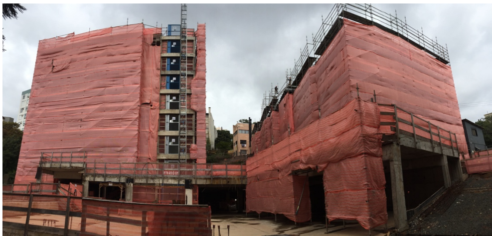
Figura 24 – Empreendimento em andamento
