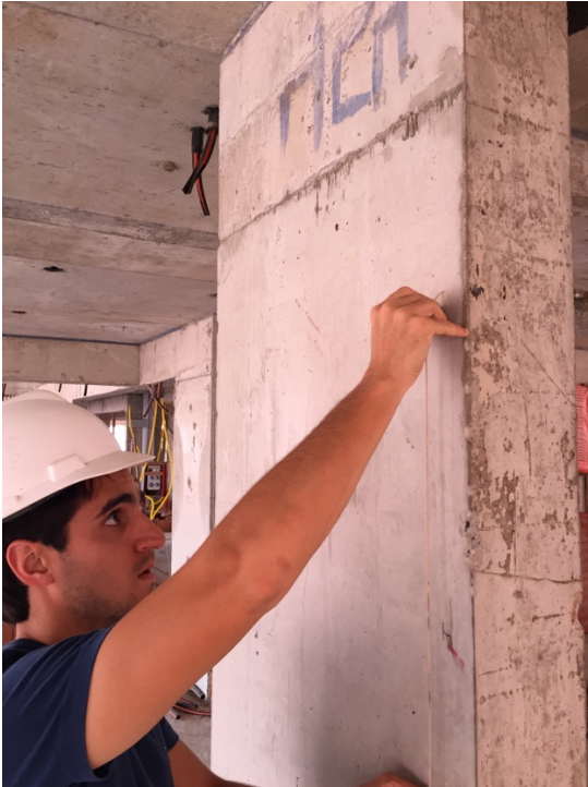
Figura 34 (a) – Prumo na face maior de pilar
