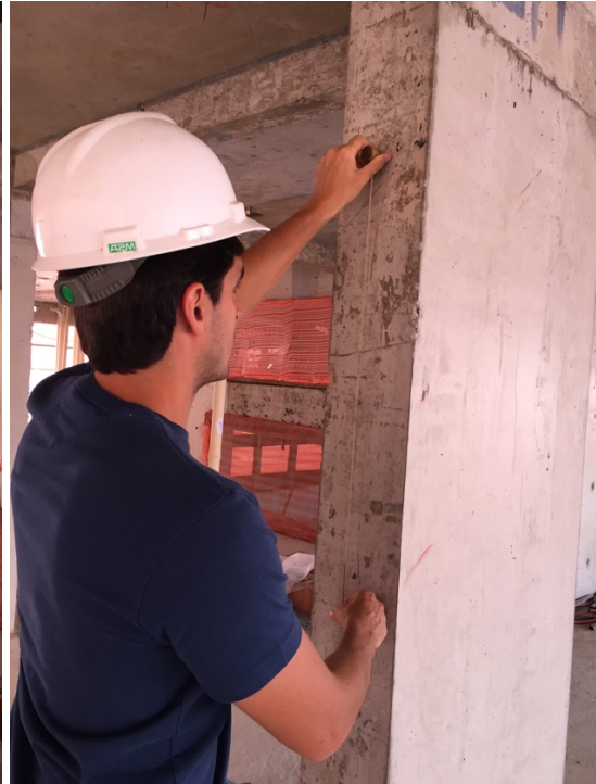
Figura 34 (b) – Prumo na face menor de pilar
