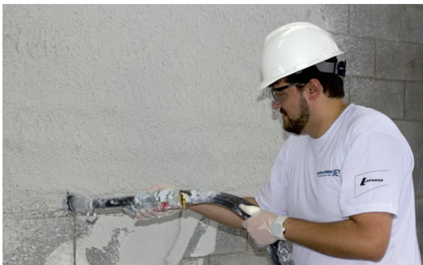
Figura 19 – Aplicação de projeção de revestimento à base de gesso
