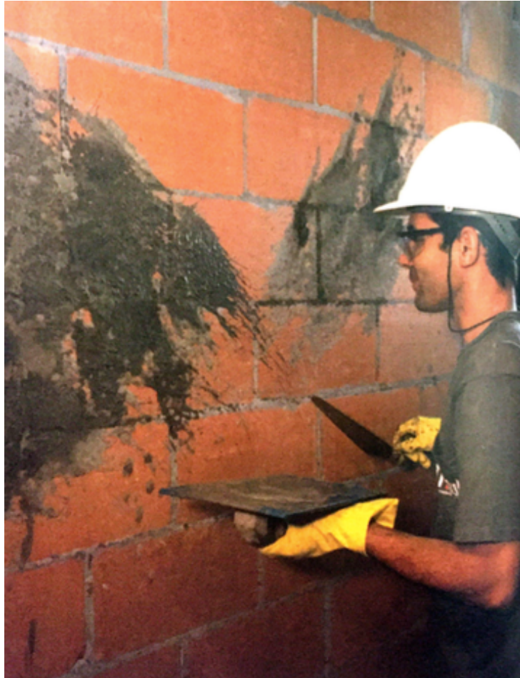
Figura 21 – Aplicação de chapisco
