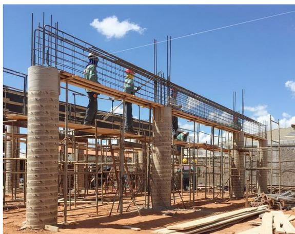
Figura 11 - Fôrmas de papelão utilizadas para pilares (Fonte: Tubominas<sup>10</sup>)
