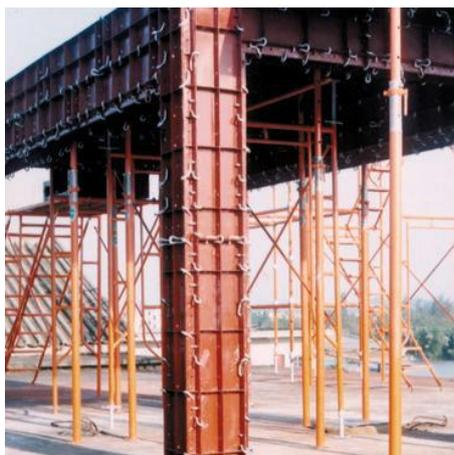
Figura 7 – Sistema de Fôrma de Aço (Fonte: Alibaba - New type steel formwork concrete wall forming systems, 2018<sup>6</sup>)
