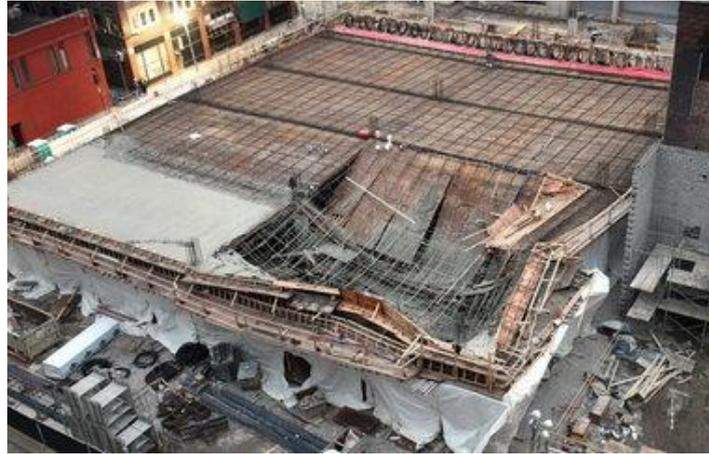
Figura 19 – Desabamento parcial de sistemas de fôrmas (Feran, 2012<sup>22</sup>)
