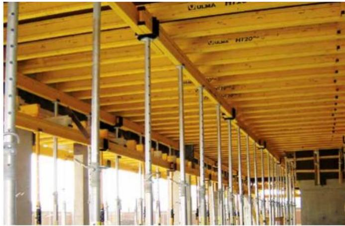
Figura 13 - Sistema misto com escoramento metálico e vigas de madeira (Fonte: ULMA, catálogo ENKOFLEX, 2018)
