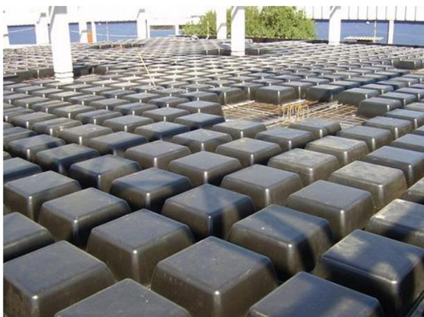
Figura 9- Laje nervurada com cubetas em PVC (Fonte: Catálogo Digital de Detalhamento da Construção do Curso de Arquitetura e Urbanismo da Feevale – Lajes Nervuradas<sup>8</sup>)
