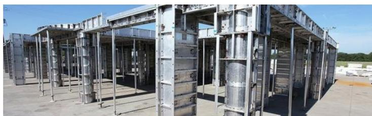
Figura 8 – Sistema de Fôrma de alumínio (Fonte: Constata Construções LTDA<sup>7</sup> - O que você deve saber sobre fôrmas para concreto)
