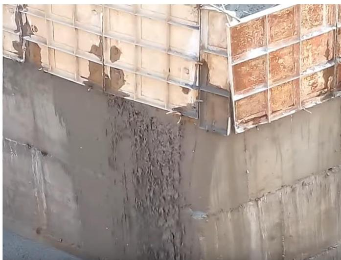
Figura 20 – Vazamento de concreto em pilar de ponte - Fonte: Youtube. Visto em novembro de 2018
