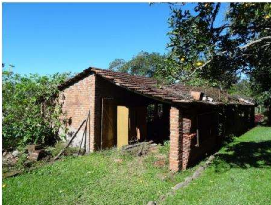
Figura 8 – Antiga estrebaria, localizada na cidade de Feliz no RS
