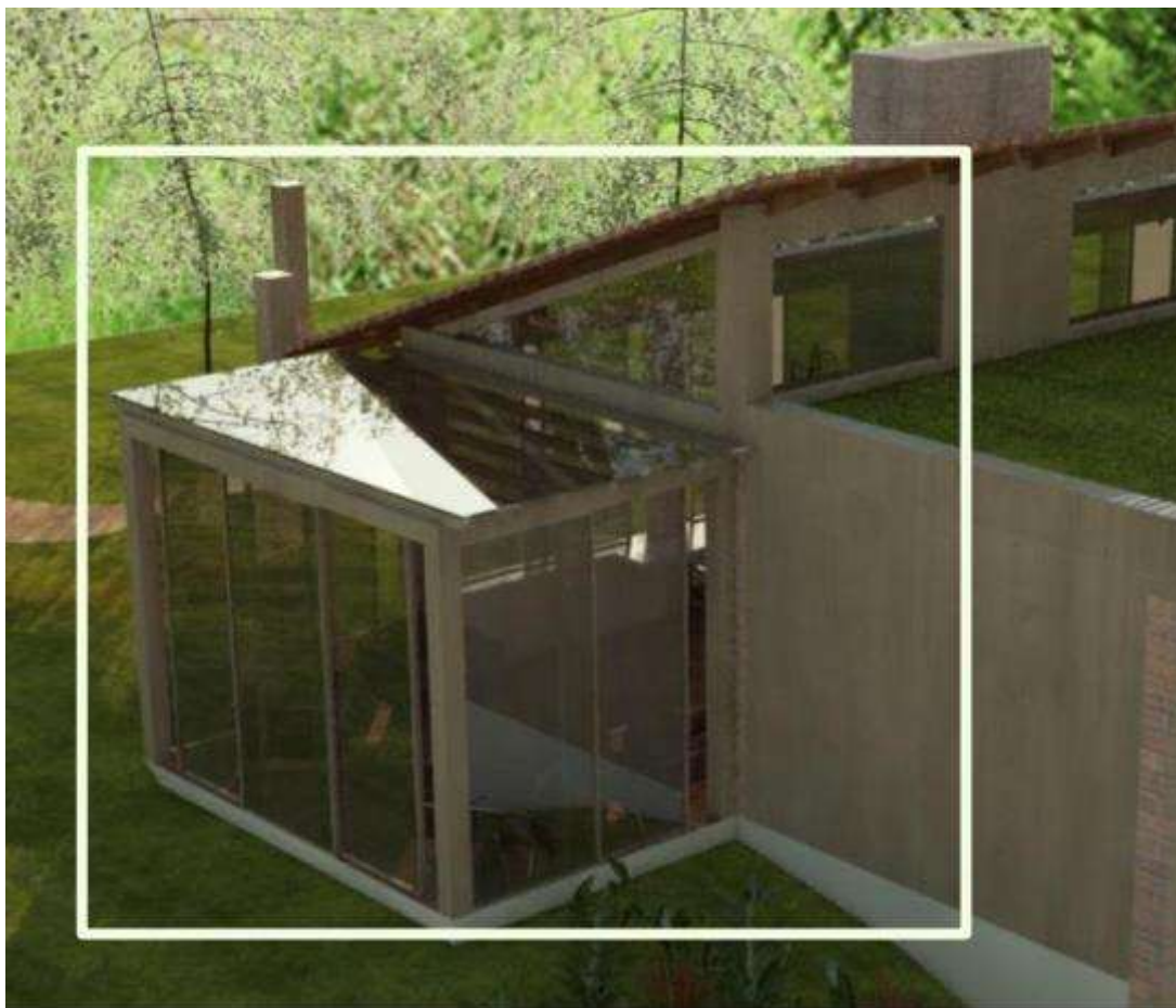
Figura 20 – Parede de vidro dupla
