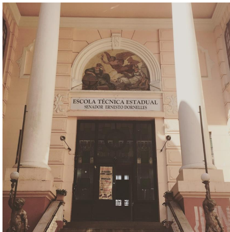
Figura 2 – Porta de entrada do prédio da Escola Fonte: Arquivo pessoal
