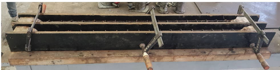
Figura 35 – Fixação das chapas nas laterais das vigas
