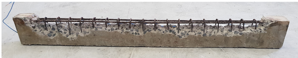
Figura 33 – Viga após a remoção do concreto para execução do reparo
