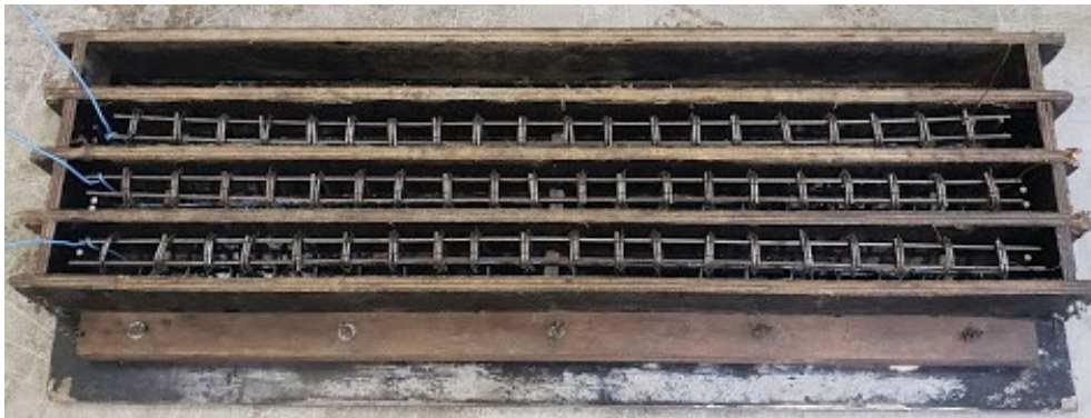
Figura 23 – Armaduras posicionadas e prontas para concretagem
