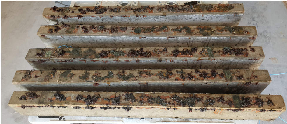
Figura 31 – Face inferior das vigas após o ensaio de CAIM
