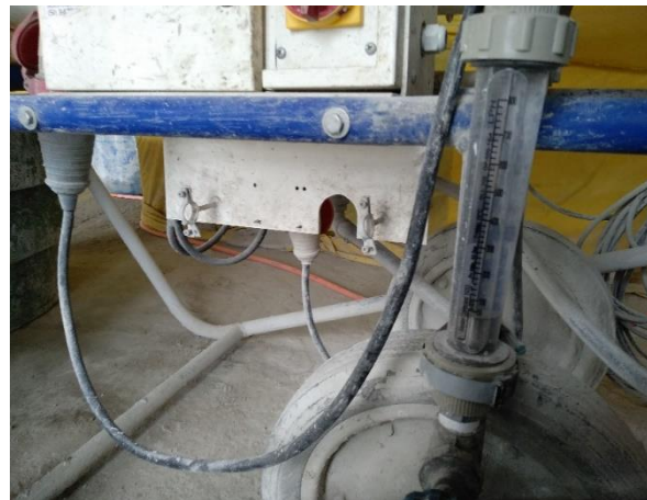
Figura 40 - Dosador de água da argamassadeira
