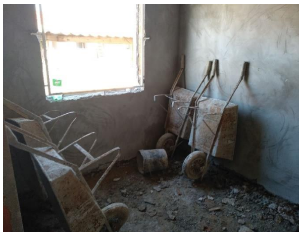
Figura 15 - Carrinhos de mão utilizados em cada central de betoneiras
