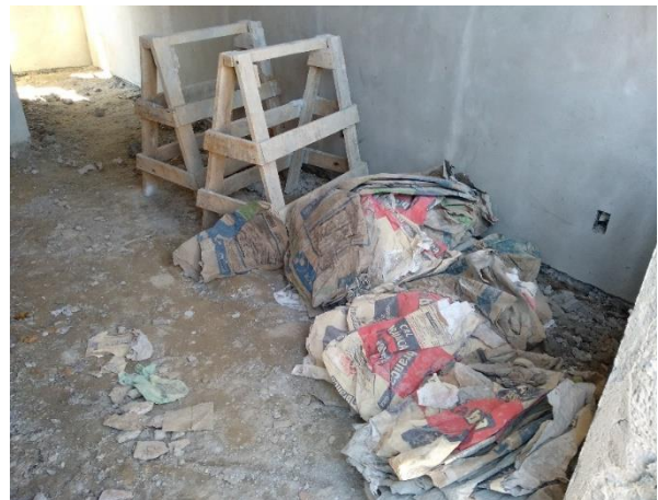
Figura 20 - Estoque de sacos de cal e cimento utilizados
