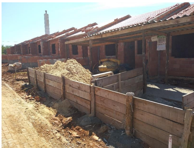
Figura 11 - Central de trabalho de produção de argamassa
