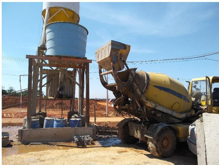
Figura 23 - Equipamento utilizada para mistura de argamassa estabilizada
