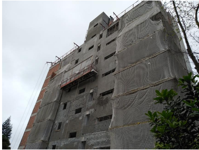
Figura 41 - Revestimento de fachada em argamassa na obra
