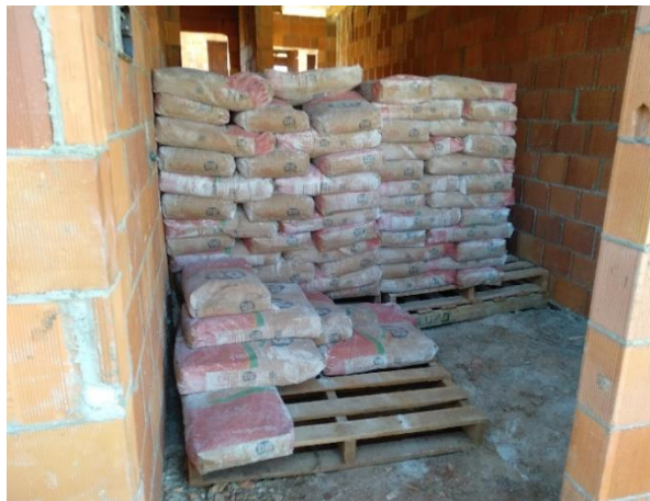
Figura 19 - Estoque de cal em localizados em uma casa do canteiro
