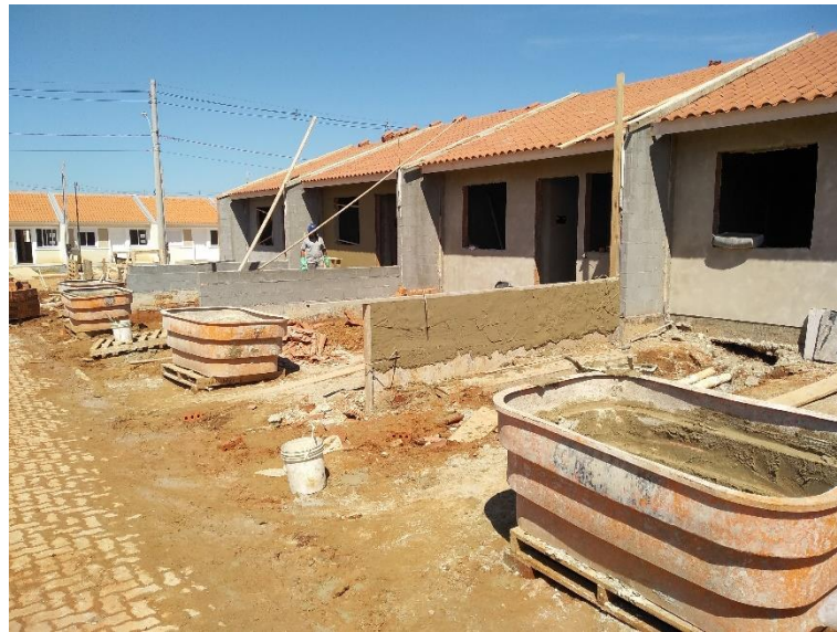
Figura 24 - Localização das caixas de armazenamento de argamassa em frente as casas
