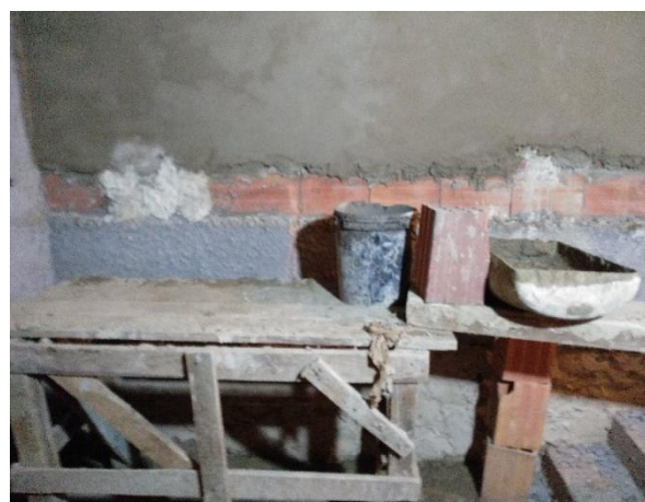
Figura 54 - Plataformas de elevação para execução de revestimento
