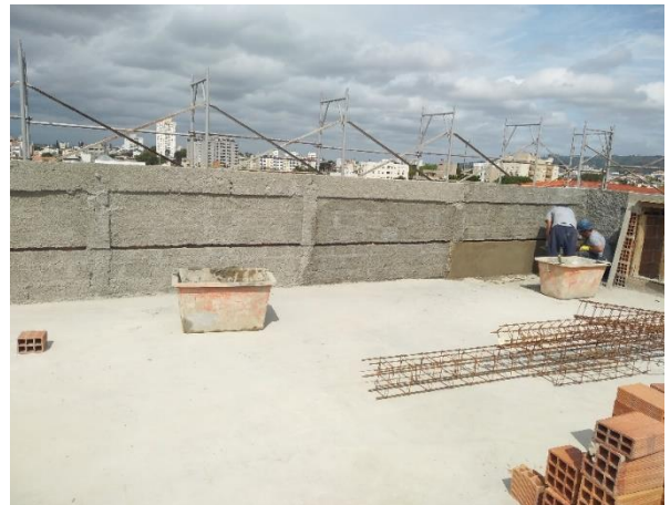
Figura 51 - Espaçamento das caixas de argamassa para uso no revestimento
