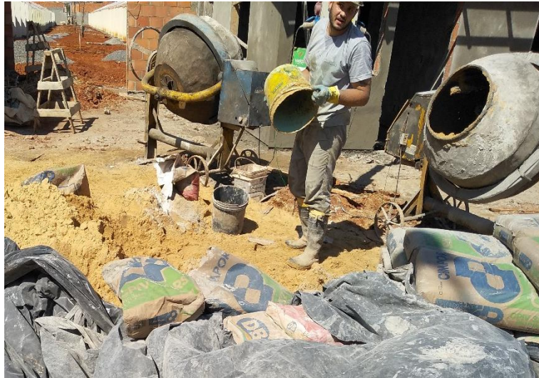
Figura 14 - Produção de argamassa em betoneiras
