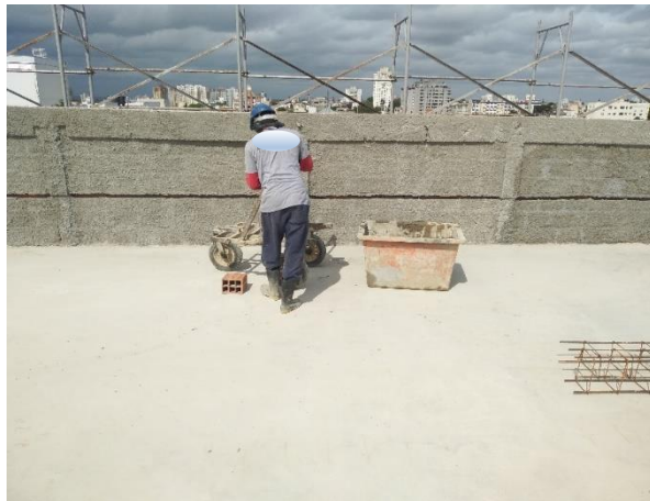
Figura 50 - Posicionamento das caixas de argamassa
