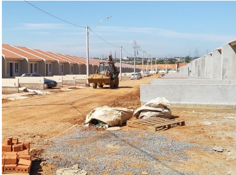
Figura 18 - Transporte da baía central até a baía secundária via retroescavadeira
