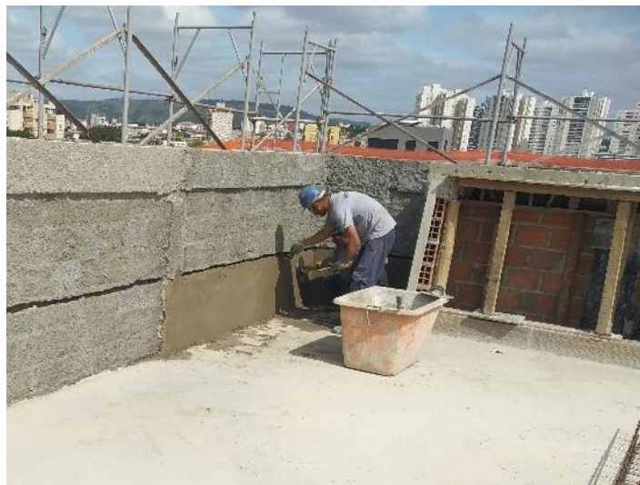
Figura 52 - Execução de revestimento de argamassa
