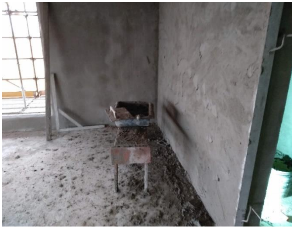
Figura 33 - Local de aplicação da argamassa
