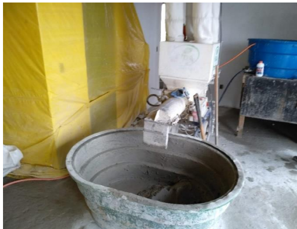
Figura 39 - Argamassadeira e caixa de armazenamento no pavimento de trabalho
