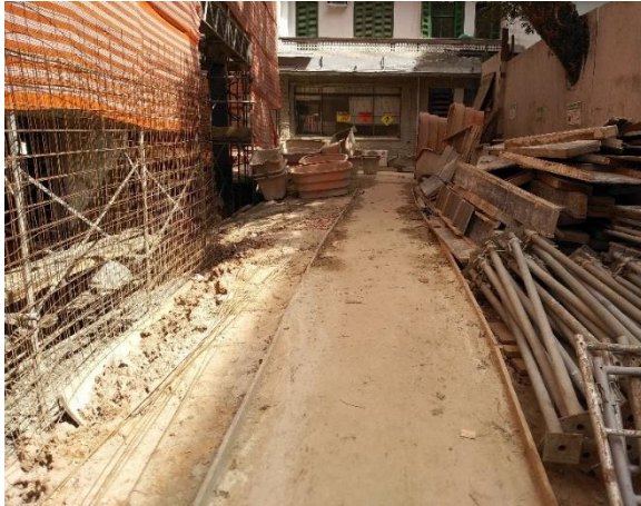
Figura 46 - Corredor de circulação para transportes no térreo
