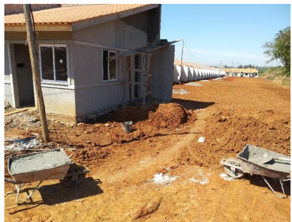
Figura 16 - Transporte da argamassa via carrinho de mão
