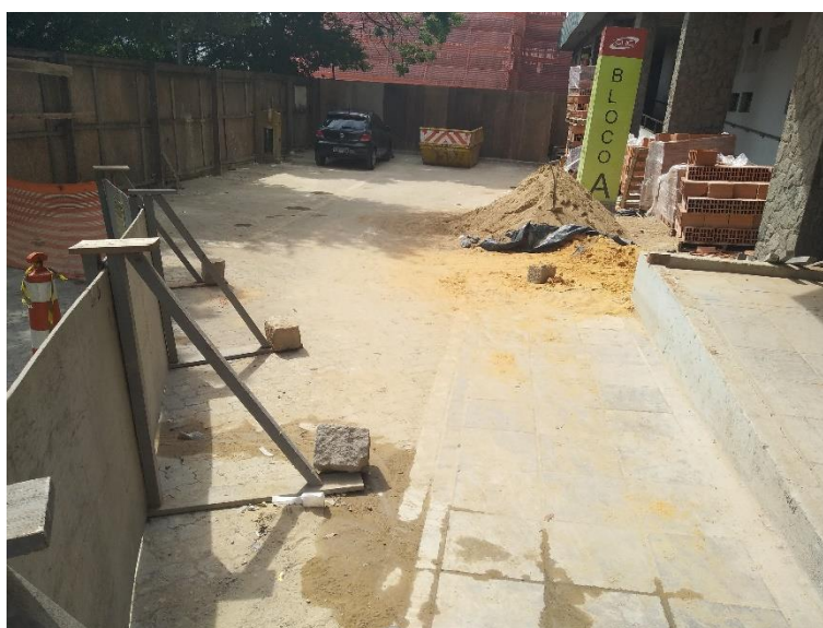
Figura 44 - Local de descarregamento de caminhão no acesso de entrada da obra
