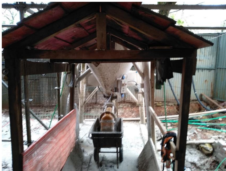
Figura 27 - Silo com misturador acoplado na obra
