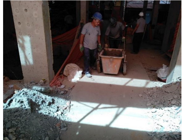
Figura 47 - Movimentação de argamassa no térreo
