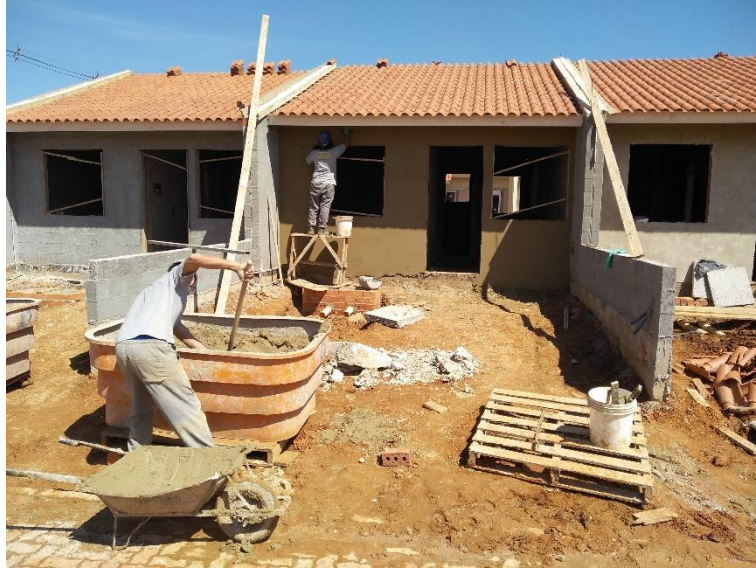
Figura 25 - Abastecimento do carrinho para transporte ao local de aplicação
