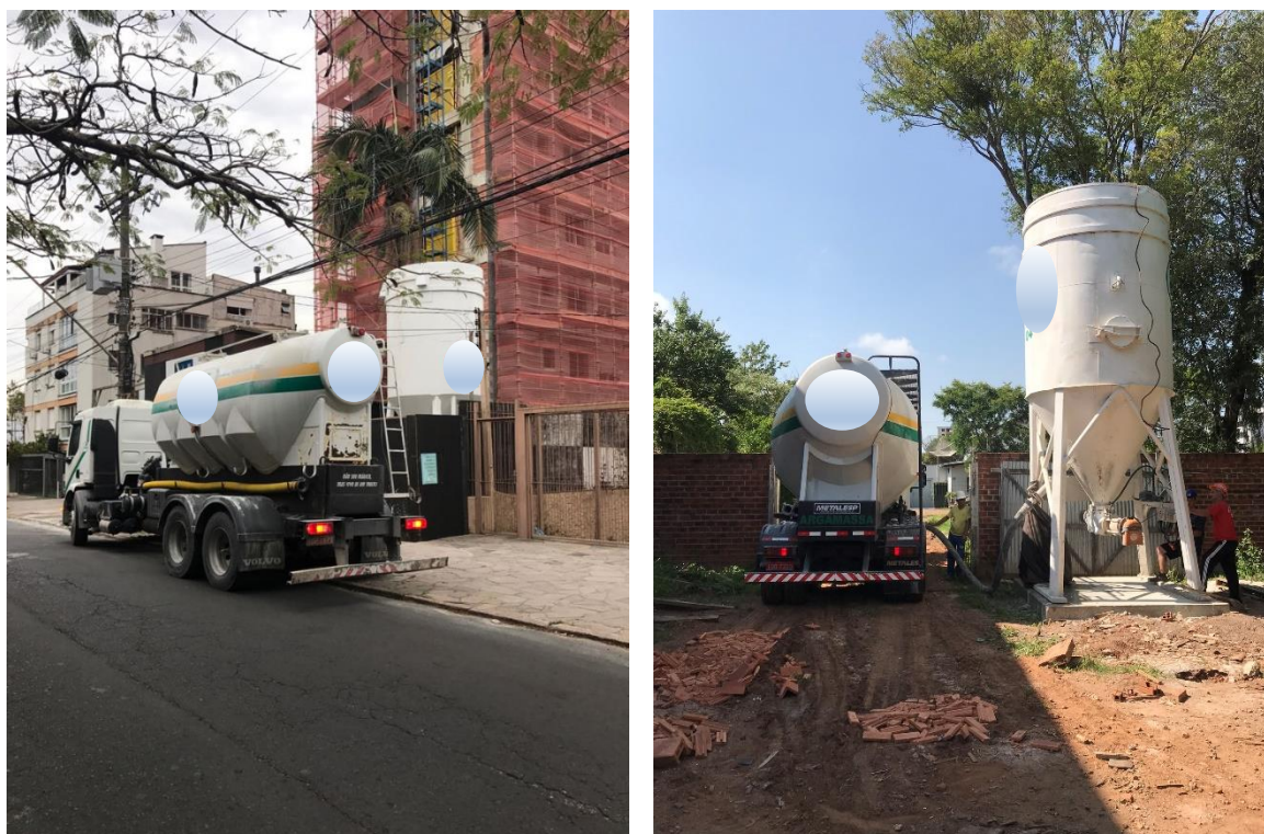
Figura 37 - Exemplos de abastecimento de silos em obras
