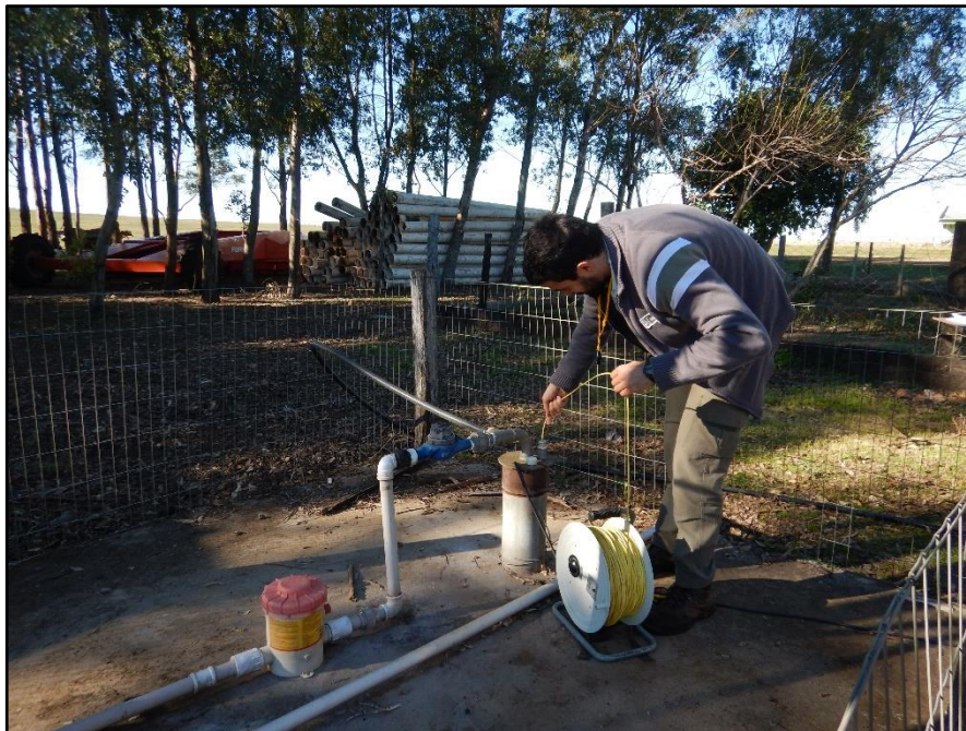
Foto 3. Nível estático do poço sendo medido com a sonda a qual possui sensor elétrico que indica o momento em que a ponta toca na água (Foto: Marcos Leão).
