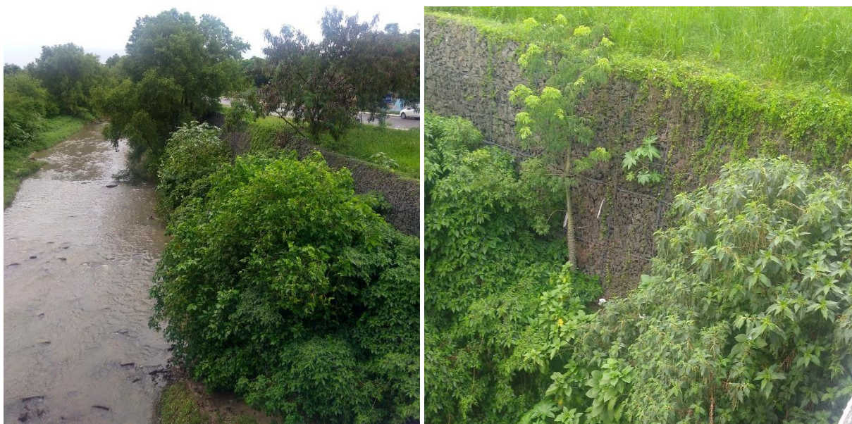
Figura 49 - Trecho gabionado do arroio Cadena, localizado na Avenida Maestro Roberto Barbosa Ribas, nas proximidades da Vila Lídia, entre o Bairro Noal e Juscelino Kubitschek. Registro dez. 2018. Autoria: FERRARI, J.
