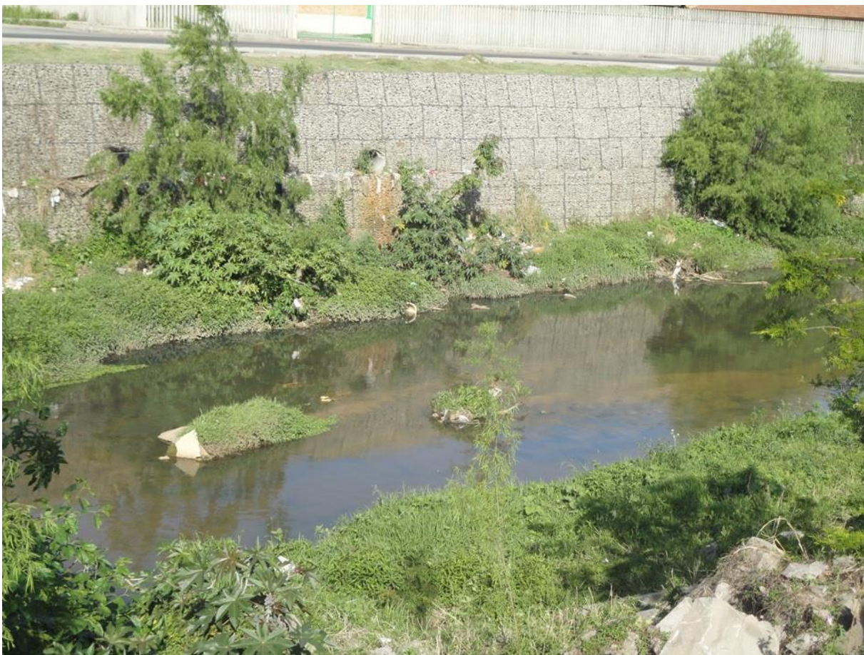
Figura 50 – Trecho gabionado do arroio Cadena, localizado na Avenida Maestro Roberto Barbosa Ribas, nas proximidades da Vila Lídia, entre o Bairro Noal e Juscelino Kubitschek. Registro set. 2011. Autoria: FERRARI, J.
