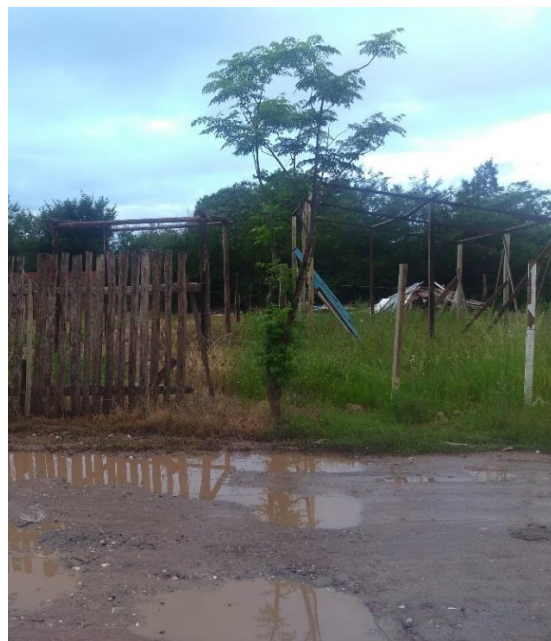
Figura 59 – Construção de novas moradias em áreas de risco. Autoria: FERRARI, J.
