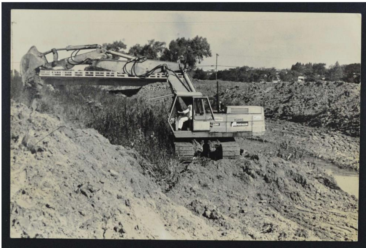
Figura 35 – Obras no canal principal do arroio Cadena para conter inundações. Fonte: Arquivo Histórico Municipal. Sem data.
