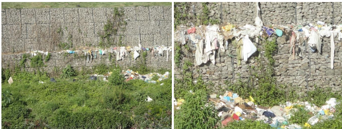
Figura 54 – Descarte de resíduos sólidos diretamente nas margens do arroio Cadena junto ao trecho gabionado, na Avenida Maestro Roberto Barbosa Ribas. Registro set. 2011. Autoria: FERRARI, J.
