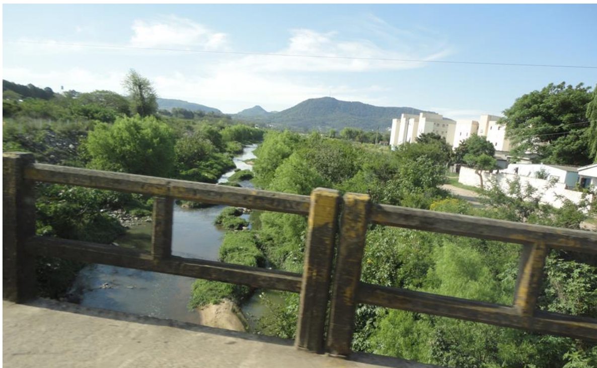
Figura 60 – Registro do curso do arroio Cadena, em trecho do canal retificado. Ao fundo, no canto direito da imagem estão os blocos do Residencial Videiras, sobre o antigo leito do arroio Cadena. Registro set. 2011. Autoria: FERRARI, J.
