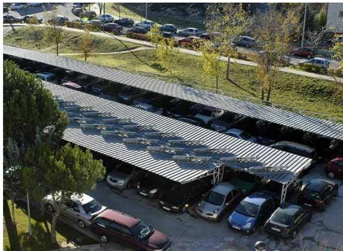
Figura 30 – Painéis sobre cobertura de estacionamento
