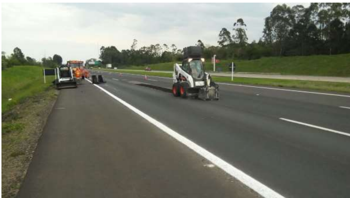
Figura 3 – Processo de fresagem e recomposição asfáltica na rodovia BR-290/RS
