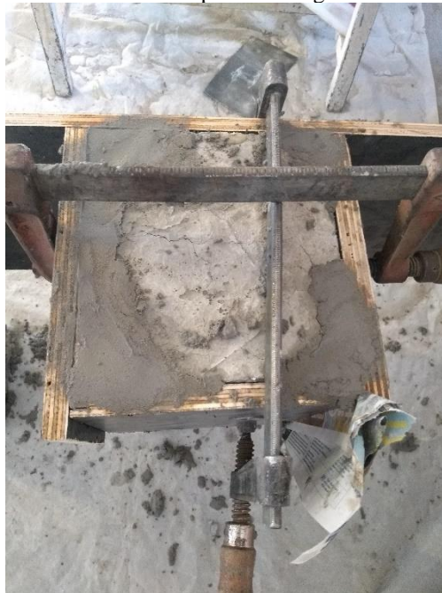
Figura 26 – Procedimento de reparo com argamassa de reparo rápido
