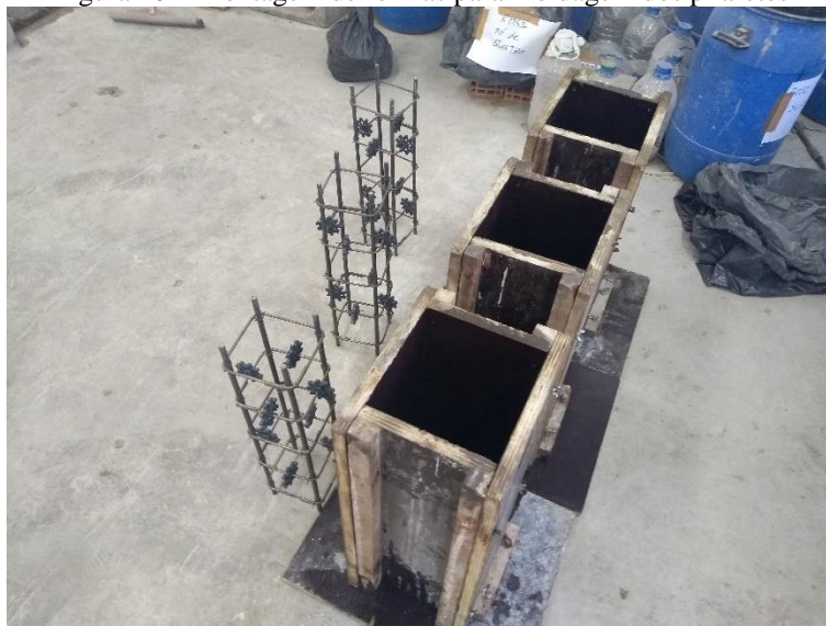
Figura 20 – Montagem de fôrmas para moldagem dos pilaretes
