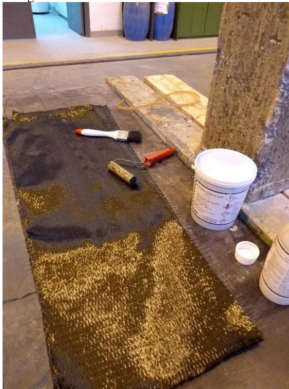
Figura 29 – Faixas de tecido de fibra de carbono
