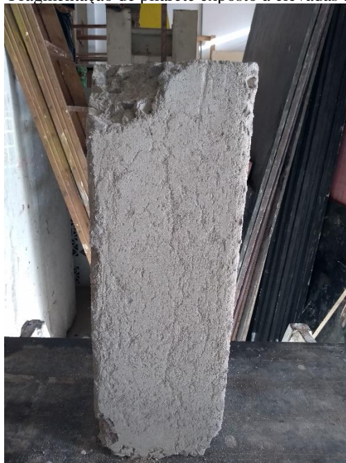
Figura 25 – Fragmentação de pilarete exposto à elevadas temperaturas
