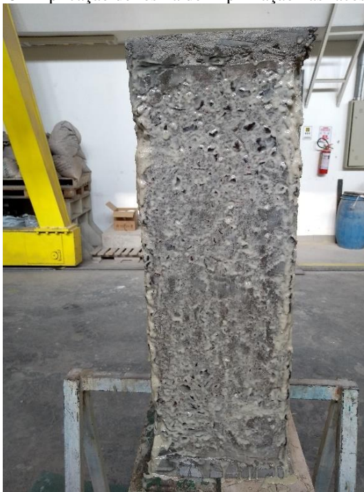
Figura 28 – Aplicação de resina de imprimação nas faces do pilar
