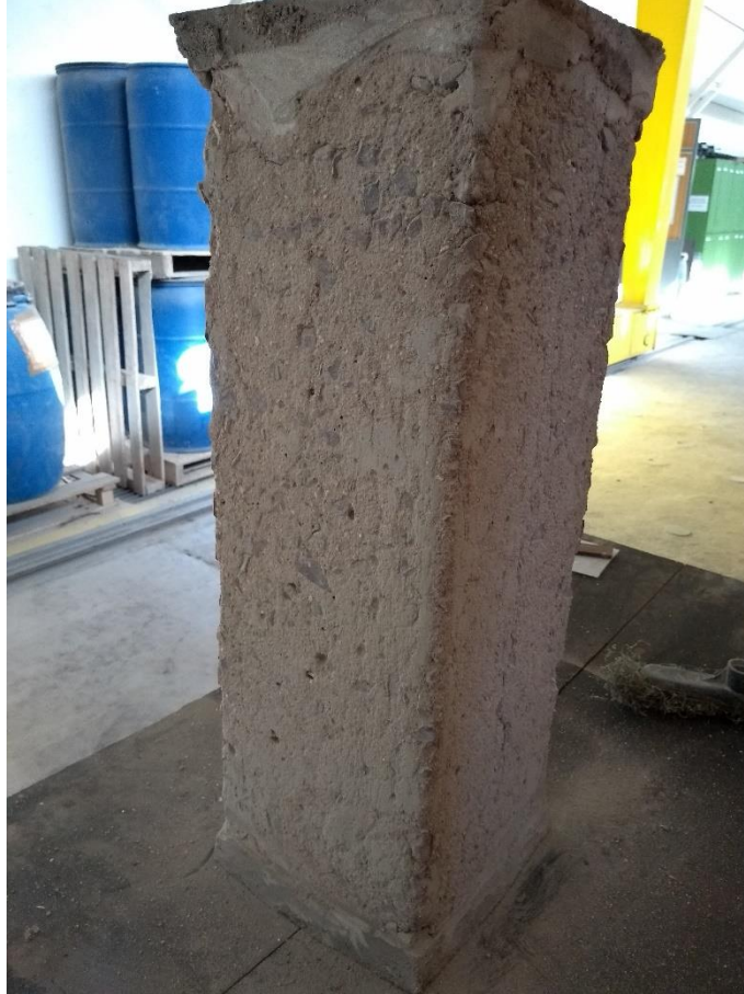
Figura 27 – Superfície escarificada e cantos arredondados executados
