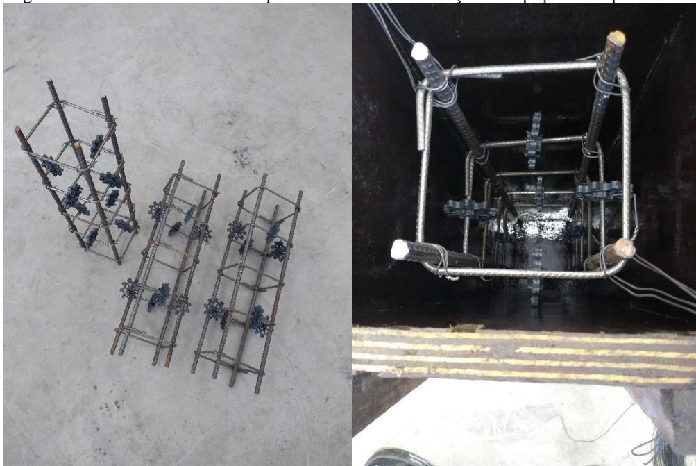
Figuras 17 – Armadura montada e posicionada com a utilização de espaçadores tipo “roseta”
