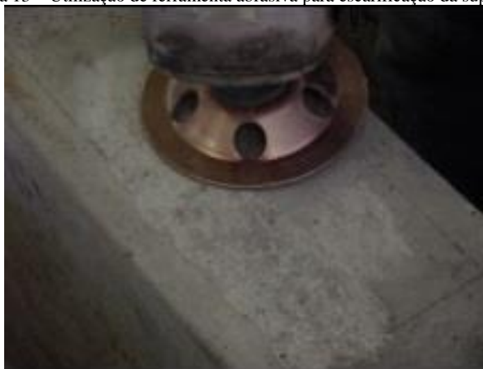
Figura 13 – Utilização de ferramenta abrasiva para escarificação da superfície
