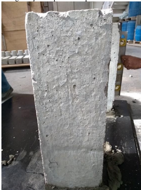
Figura 24 – Degradação de pilarete exposto a elevadas temperaturas
