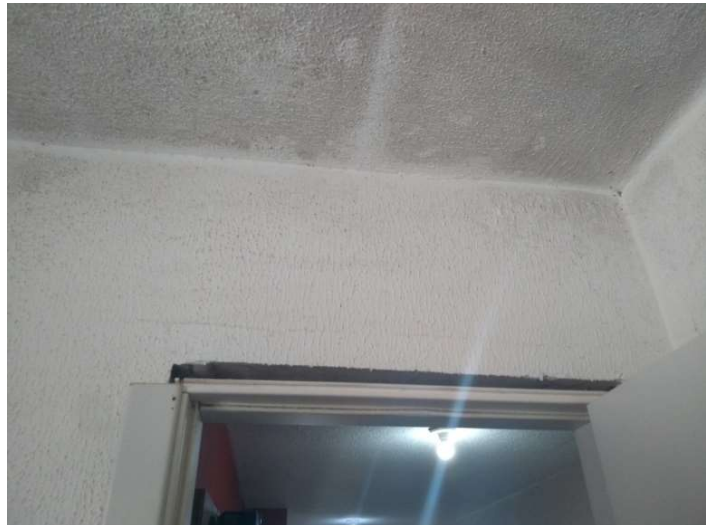
Figura 34A, Figura 34B, Figura 34C e Figura 34D – Mofos e bolores nas paredes
