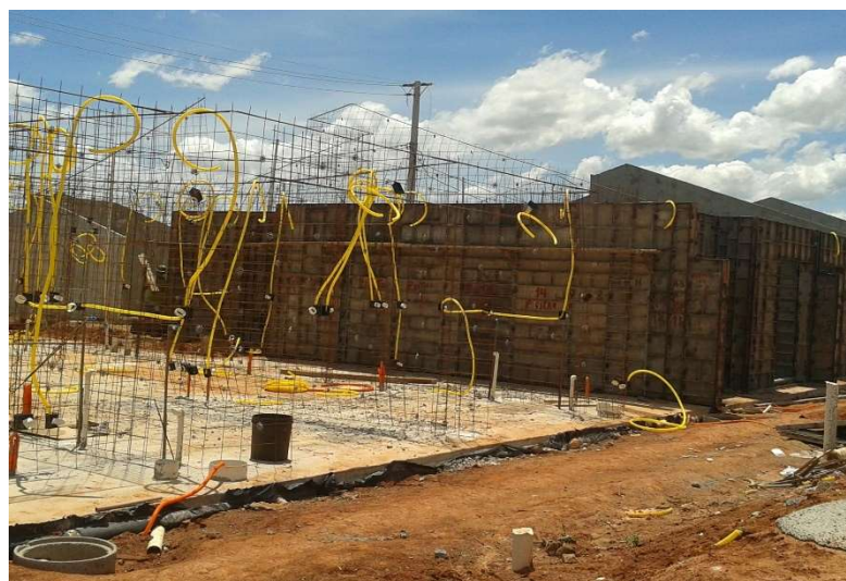
Figura 2 – Impermeabilização da fundação
