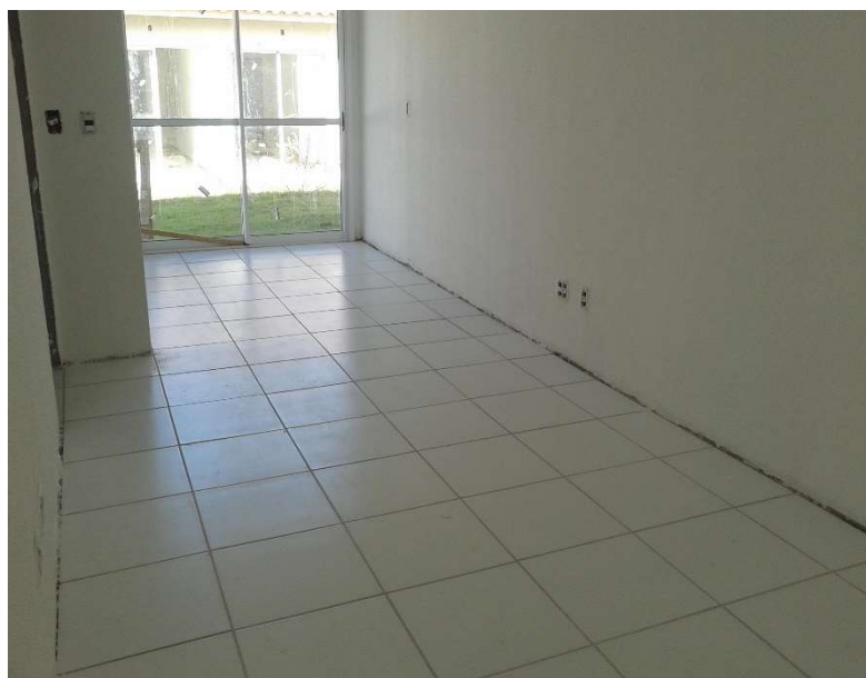
Figura 8 – Cerâmicas instaladas
