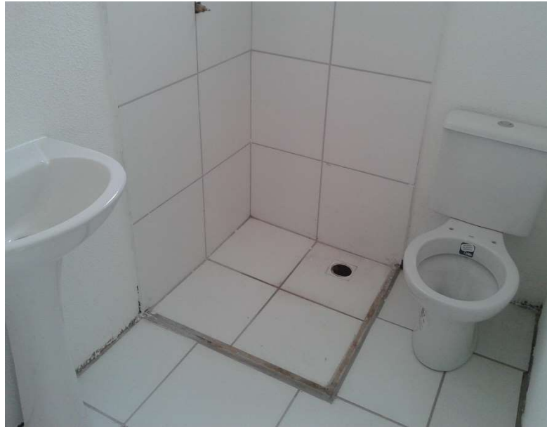
Figura 9 – Cerâmicas instaladas no banheiro
