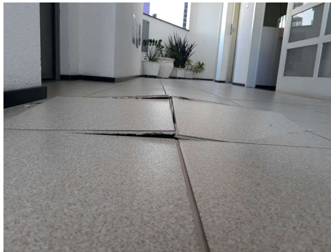
Figura 29 – Elevação de peça cerâmica
