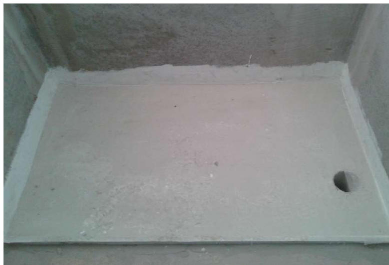
Figura 4 – Impermeabilização do box
