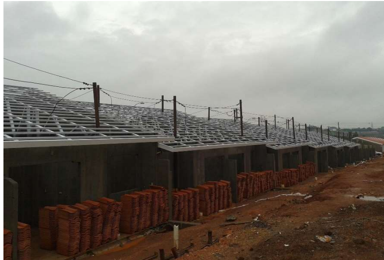
Figura 7 – Estrutura metálica telhado
