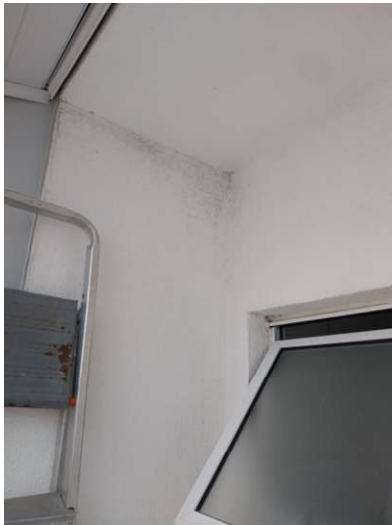
Figura 34A, Figura 34B, Figura 34C e Figura 34D – Mofos e bolores nas paredes
