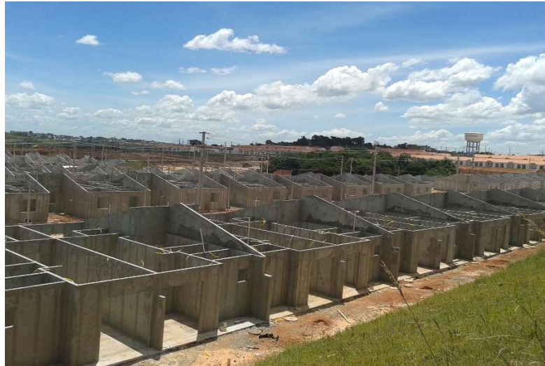
Figura 43 – Paredes de concreto
