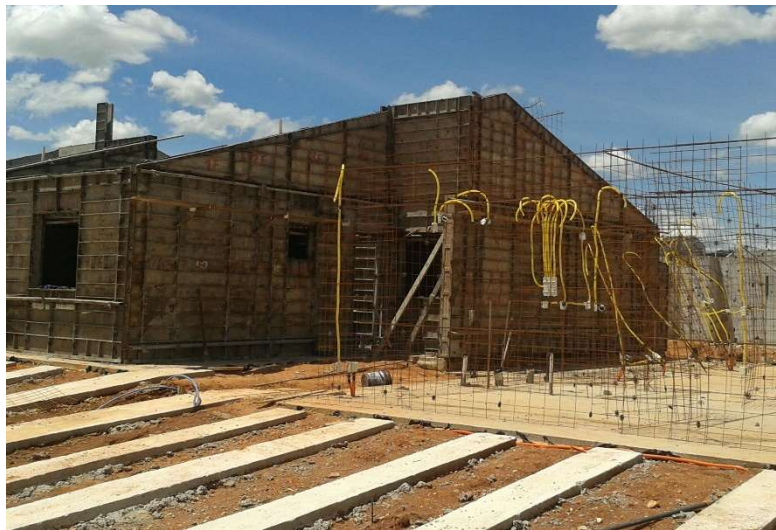
Figura 2 – Armaduras paredes
