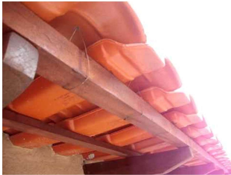
Figura 15 – Amarração de telhas em beirais
