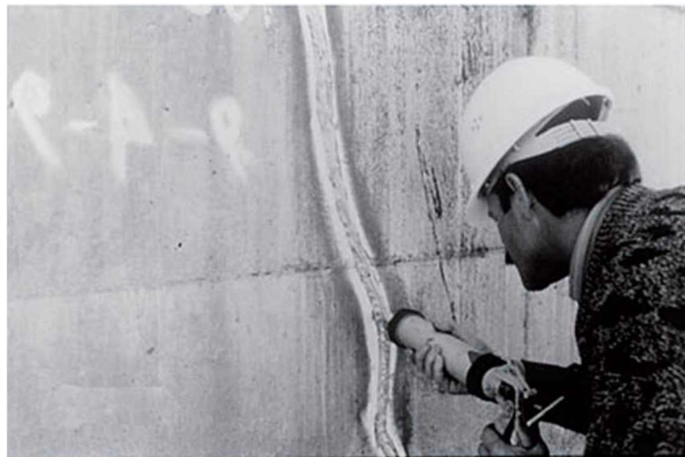
Figura 27 – Técnica da injeção em fendas
