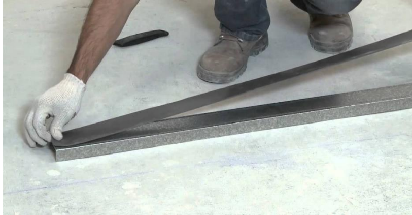
Figura 21 – Aplicação da banda acústica
