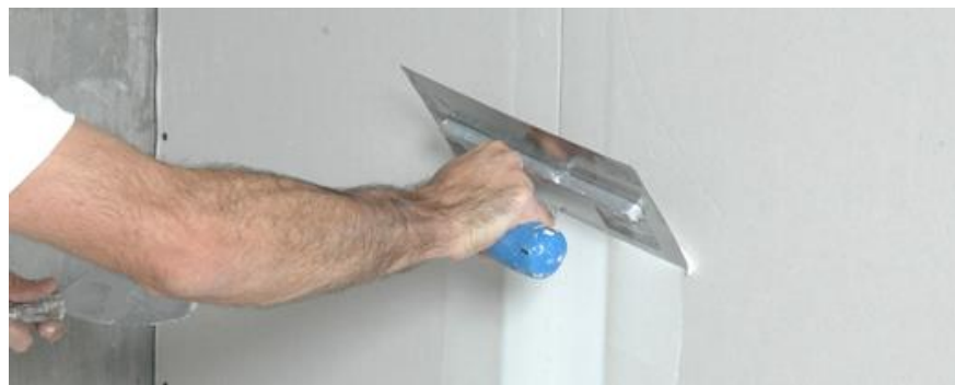
Figura 26 – Tratamento das juntas
