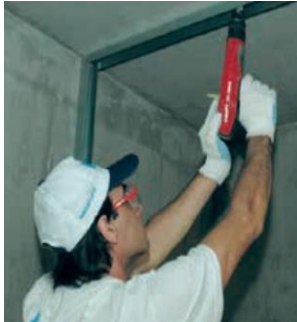
Figura 36 – Colocação de perfil no teto
