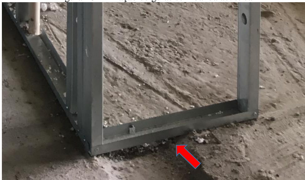
Figura 28 – Fixação de guias sem banda acústica
