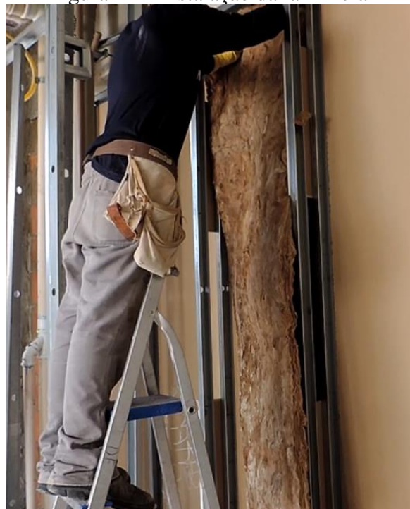
Figura 42 – Instalação da lã mineral
