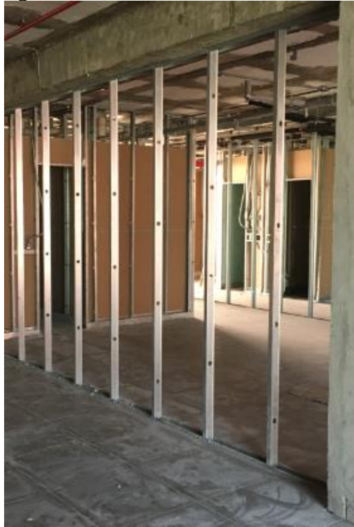
Figura 32 – Montantes e Guias instalados
