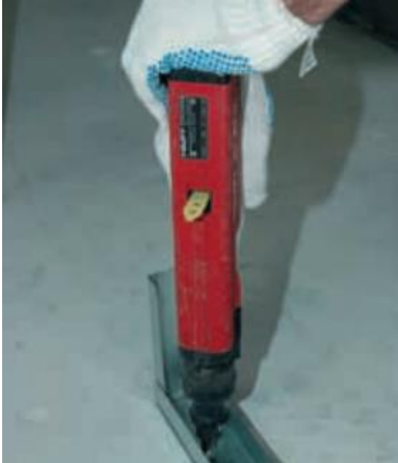
Figura 37 – Fixação de guias no piso
