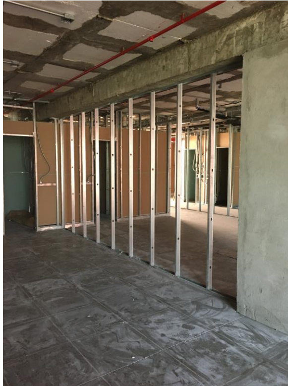
Figura 40 – Guias e montantes instalados com banda acústica
