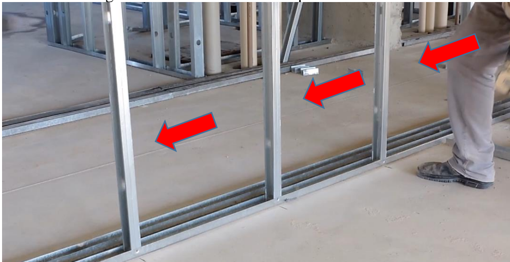
Figura 31 – Montantes virados para o mesmo lado
