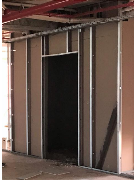
Figura 41 – Fechamento com placas de gesso acartonado de um lado da parede
