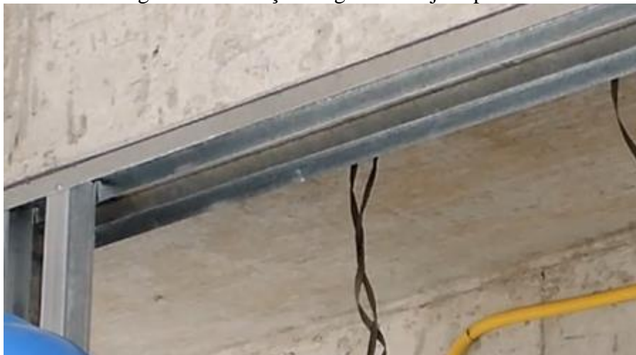
Figura 39 – Fixação de guias na laje superior
