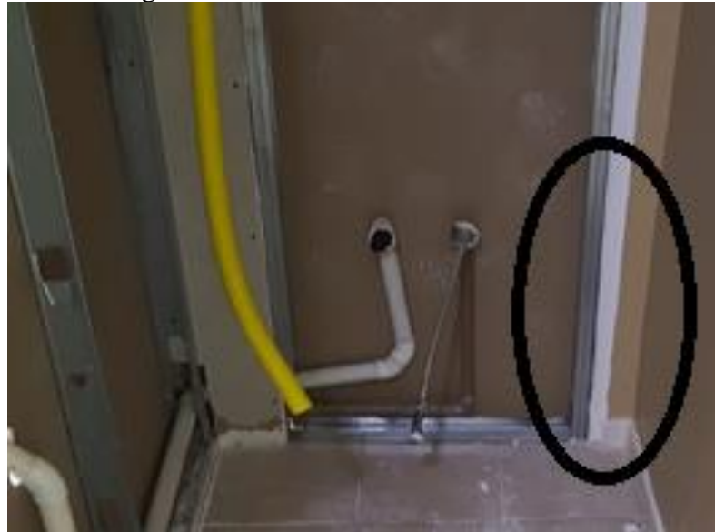
Figura 29 – Montantes sem banda acústica
