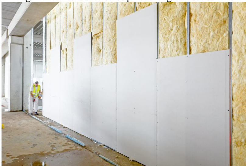
Figura 43 – Fechamento da parede de gesso acartonado
