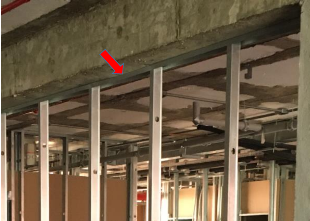
Figura 30 – Guias em contato direto com a estrutura superior
