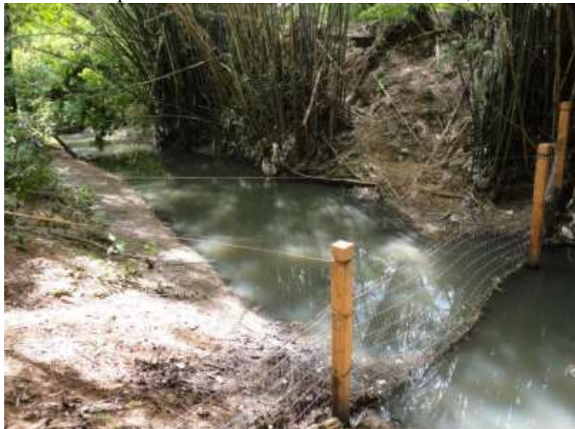
Figura 14 – Barreira para reter RS instalada no Arroio Cancela, em Santa Maria/RS.
