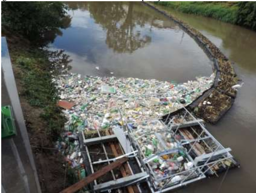
Figura 8 – Resíduos retidos no início da operação da Ecobarreira do Dilúvio.
