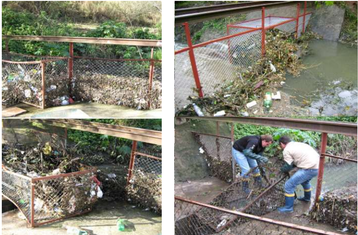
Figura 12 – Gaiola com cesto removível projetada com o objetivo de coletar RS na bacia Esperança, em Santa Maria/RS.
