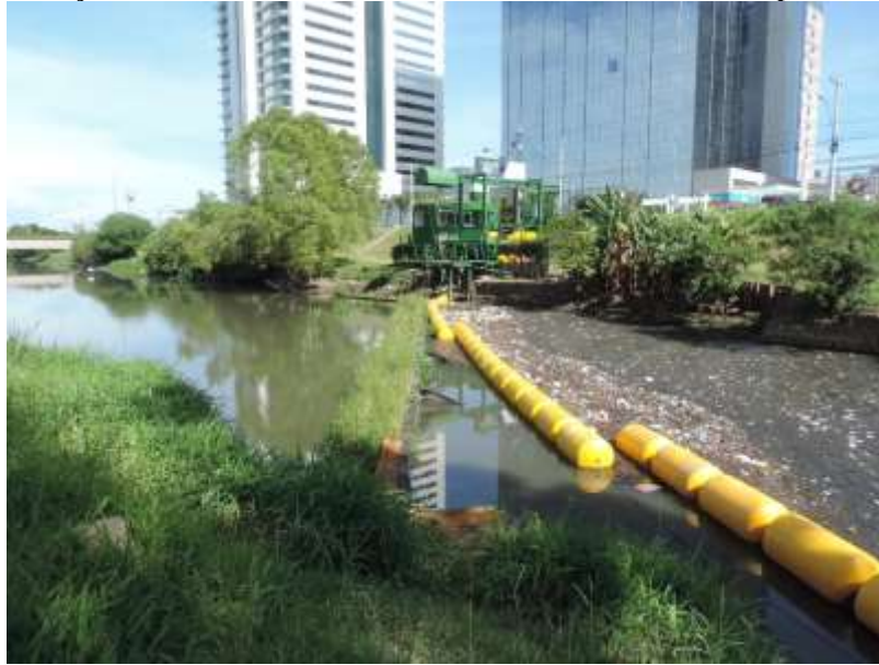
Figura 9 – Substituição da Ecobarreira do Dilúvio, em dezembro de 2016, por módulos flutuantes.
