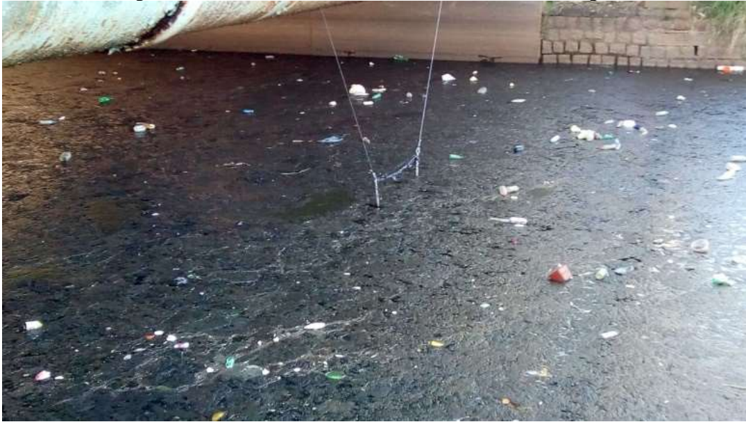
Figura 36 – Armadilha instalada no Arroio totalmente afogada.
