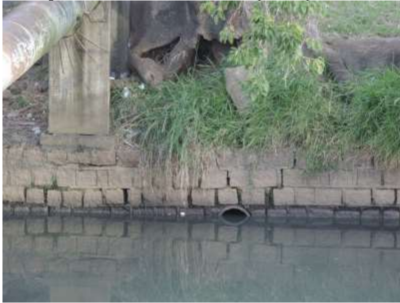
Figura 37 – Nível d'água estimado através do número de pedras aparentes no talude da margem.
