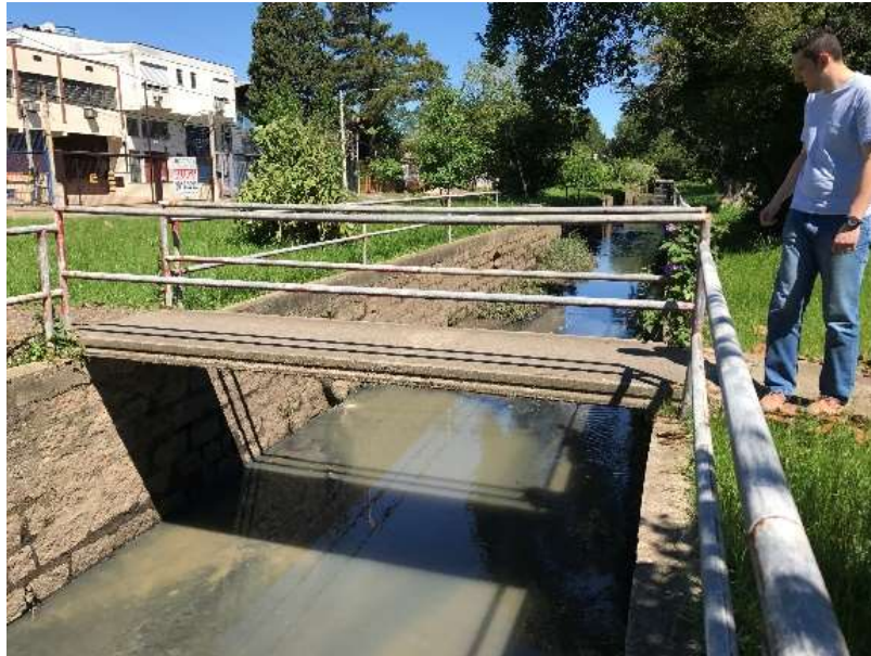
Figura 24 – Primeira ponte à montante, para pedestres, na Av. Menna Barreto, em 15 de outubro de 2017.
