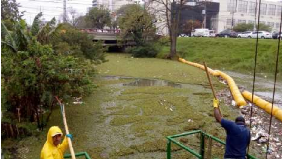
Figura 39 – Acúmulo de plantas aquáticas no Arroio atrapalhando a operação da Ecobarreira.
