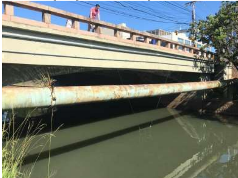
Figura 29 – Armadilha suspensa para verificar o comprimento necessário dos cabos de aço.
