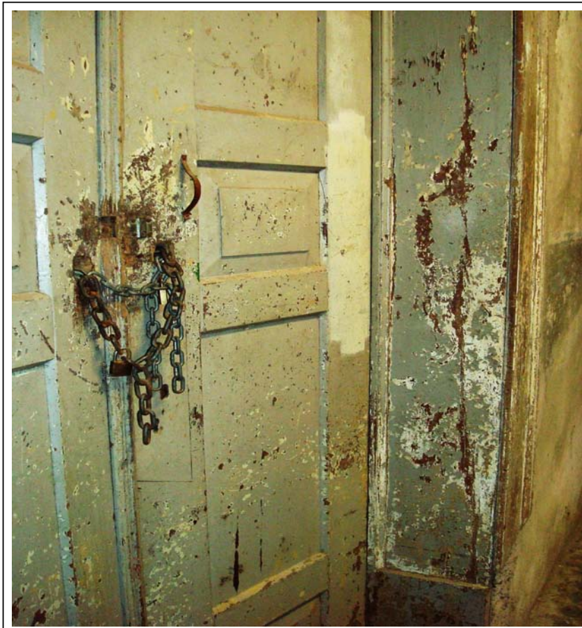
Porta Interna do bloco “B” do HPSP – 2009 Acervo do Serviço de Memória Cultural do HPSP.
