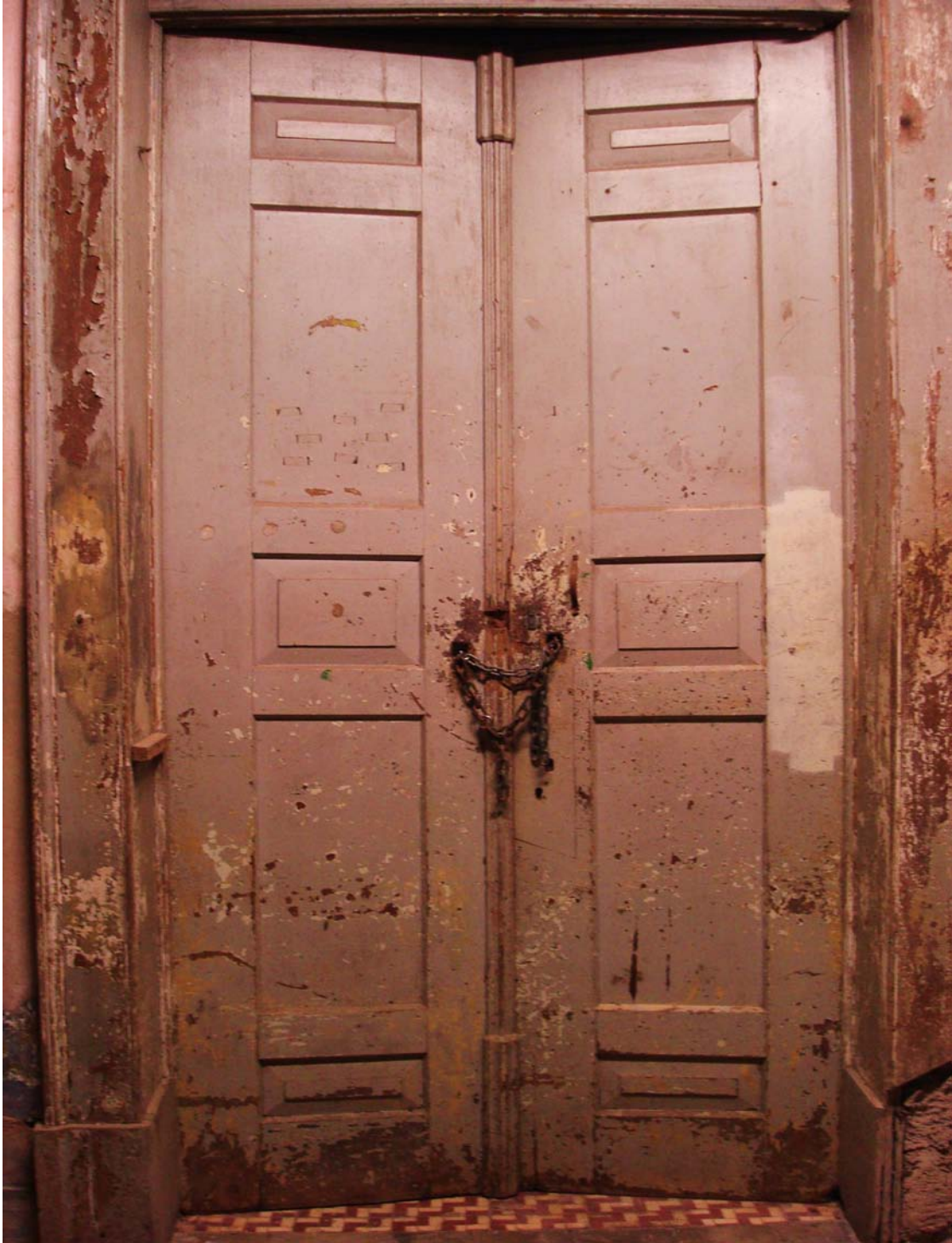
Porta interna do bloco "B" do HPSP - 2009 Acervo do Serviço de Memória Cultural do HPSP.
