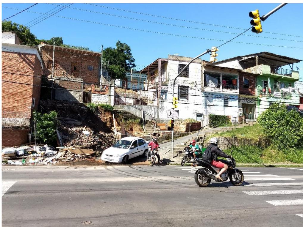
**Figura 22.** Degrau de corte mal executado associado a descarte de lixo
