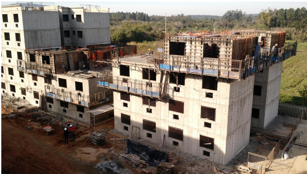
Figura 5 – Elevação de metade da estrutura em duas torres formando um pavimento
