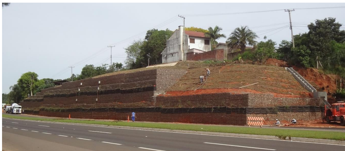
Figura 8 Fotografia da obra em etapa final.
