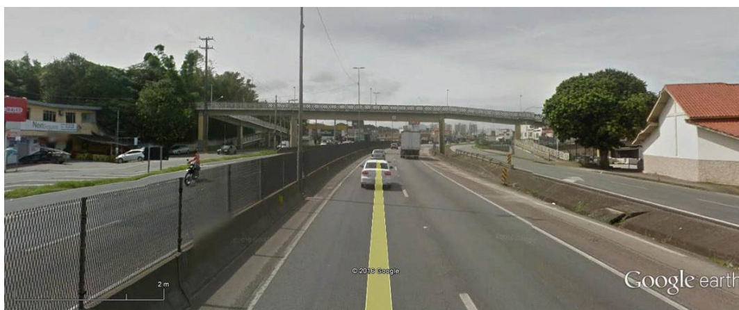
Figura 2 – Exemplo de travessia urbana em pista duplicada, cuja transposição se dá apenas em locais específicos em função da existência de barreira. Rodovia BR-101/SC. Fonte: Google earth .
