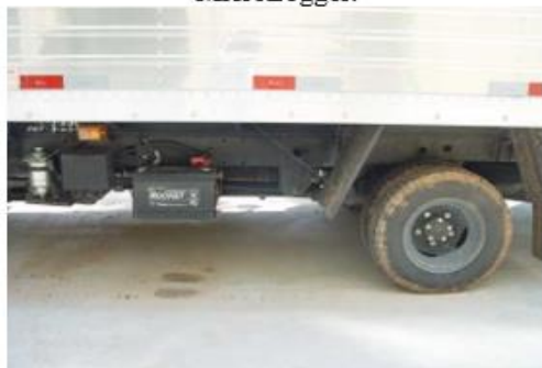
Figura A-12 – Bateria do Caminhão utilizada como alimentação do MicroLogger.
