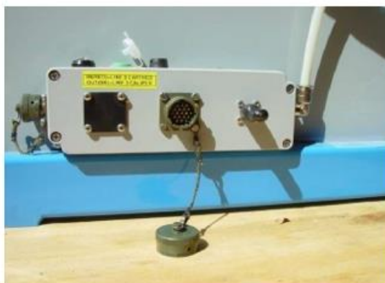
Figura A-9 – Detalhe das conexões do guincho.
