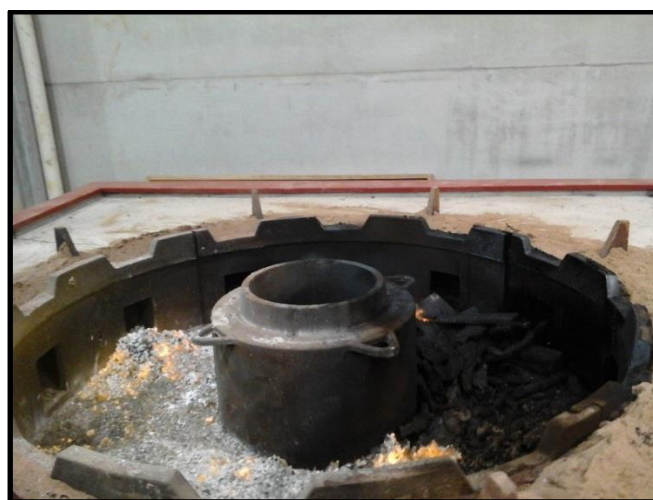
Figura 4.15. Aspecto da base do forno na saída do cilindro.
