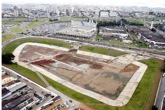
Figura 7 – Reservatório de amortecimento na Vila Paulicéia, São Bernardo do Campo, SP, fonte: ( http://www.saopaulo.sp.gov.br/eventos/governador-inaugura-piscinao-em-sao-bernardo-do-campo/ ) acessado em 21/09/2018.
