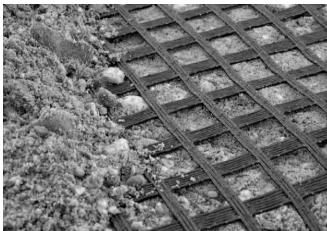
Figura 20 - Detalhe da geogrelha aplicada em camada de solo
