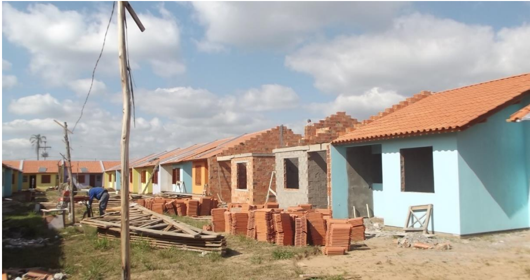
Figura 3: Canteiro de obras do Loteamento COOTRAHAB. FONTE: Acervo pessoal da pesquisadora, 2014.
