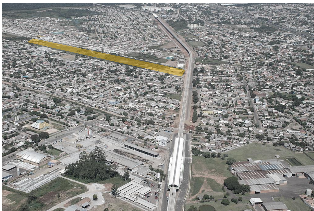
Figura 18: Extensão da linha de trem “São Leopoldo – Novo Hamburgo”: vista aérea desde a Estação Santo Afonso (NH). FONTE: Google Maps (2012), adaptada pela autora, 2018.
