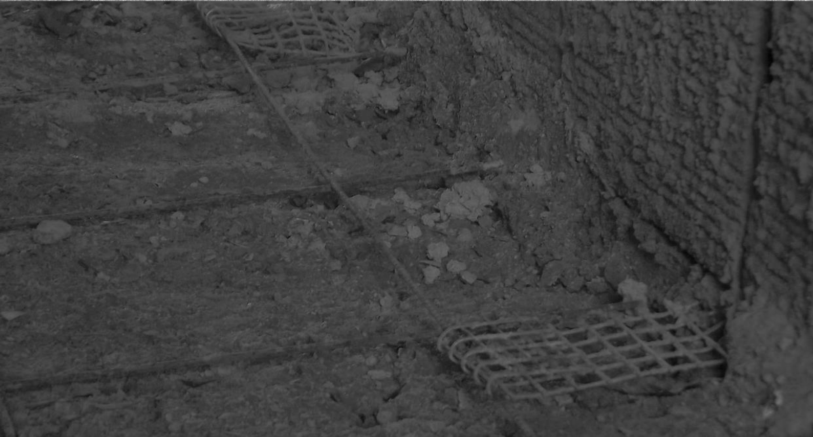
Fig. 37: "Chapisco" nas paredes. FONTE: COOTRAHAB, 2013.
