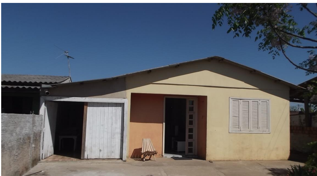
Figura 14: Unidade habitacional produzida pela Cooperativa Bom Fim, através da Resolução nº 460. FONTE: acervo pessoal da pesquisadora, 2014.
