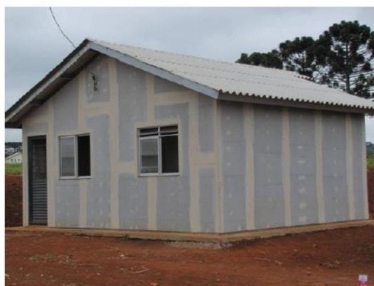
Figura 4 - Edificação térrea com fechamento em placas cimentícias
