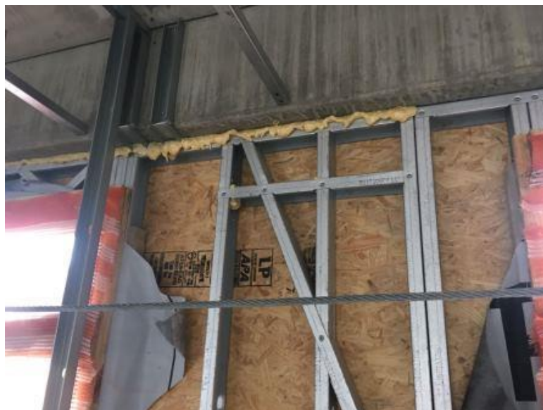
Figura 11 – Preenchimento de vão com espuma expansiva
