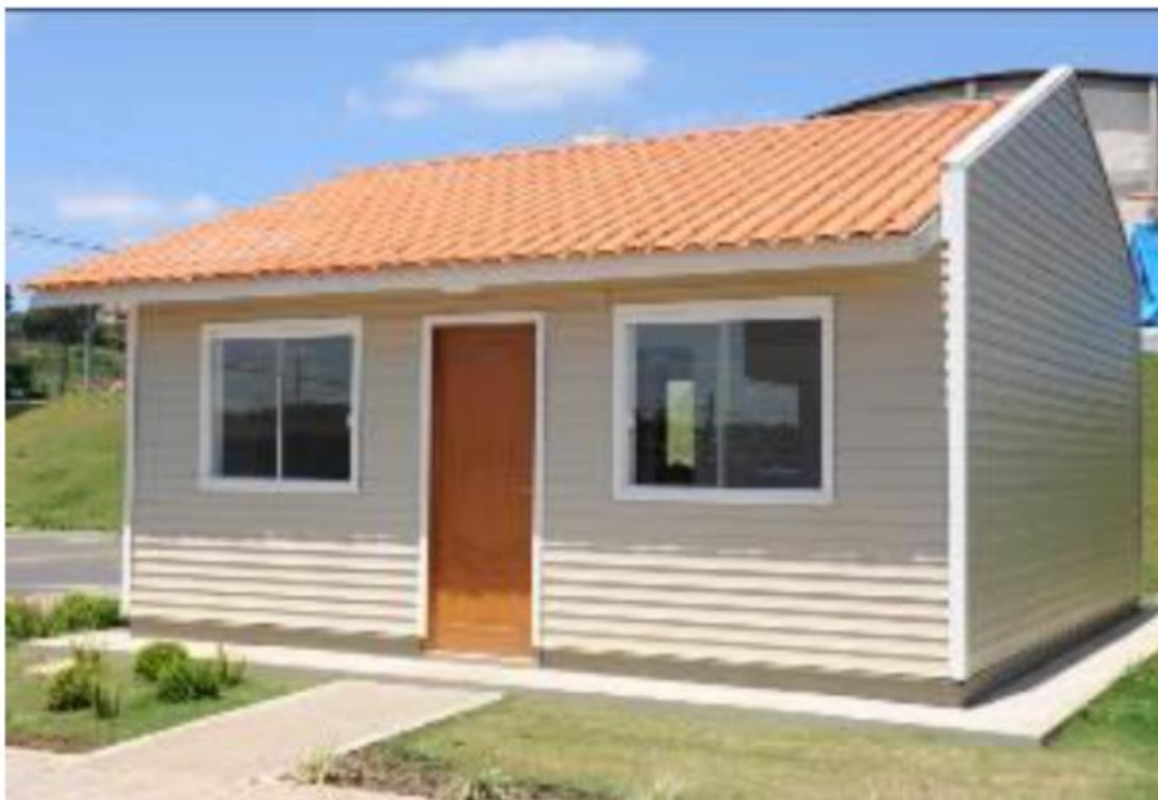
Figura 5 - Residência com acabamento em siding vinílico
