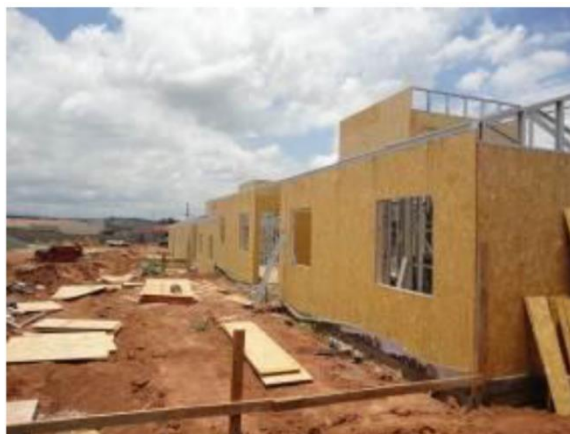
Figura 3 - Edificação com fechamento em placas OSB
