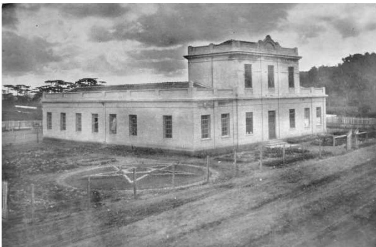
Figura 8 - Vista do edifício de administração, aulas e oficinas da Escola Industrial Elementar de Caxias, 1921.
