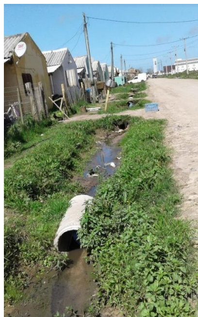
Figura 6 - Vala receptora de esgotos domésticos no município de Chuí
