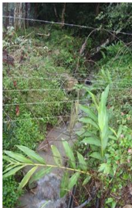
Figura 8 - Córrego receptor de águas pluviais e esgotos sanitários sem tratamento no município de Horizontina
