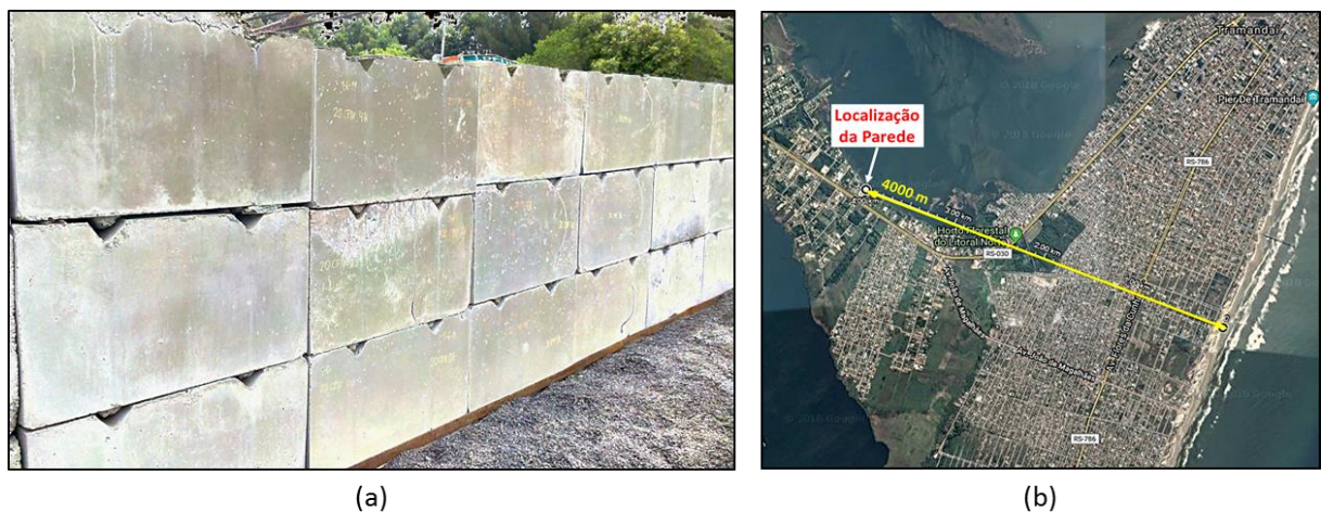
Figura 36: (a) parede construída com os blocos e (b) localização da parede em relação ao mar (disponível em: < https://www.google.com.br/maps >)
