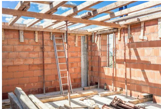
Figura 14. Produção de Lajes In Loco
