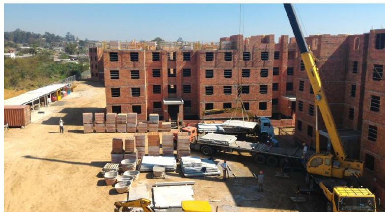
Figura 15. Organização da Obra com Lajes Pré-Moldadas
