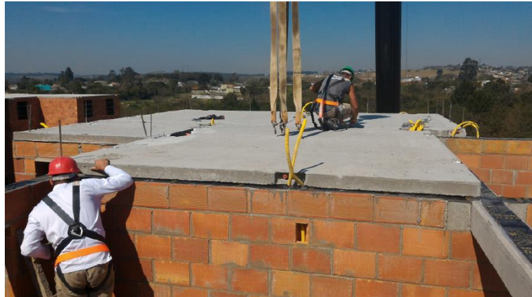
Figura 16. Instalação de Laje Pré-Moldada
