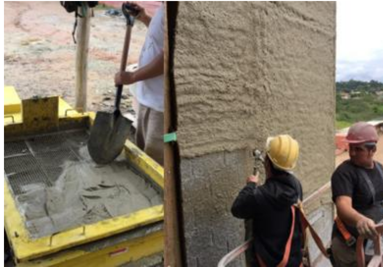
Figura 17. Aplicação de Argamassa Projetada
