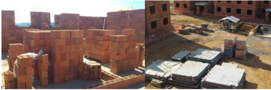
Figura 10. Organização de Materiais – Obra Alvorada 2017
