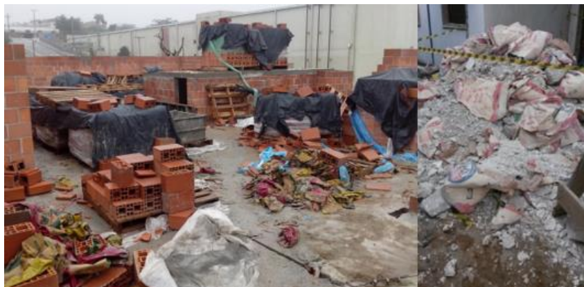
Figura 9. Organização de Materiais – Obra Porto Alegre 2015
